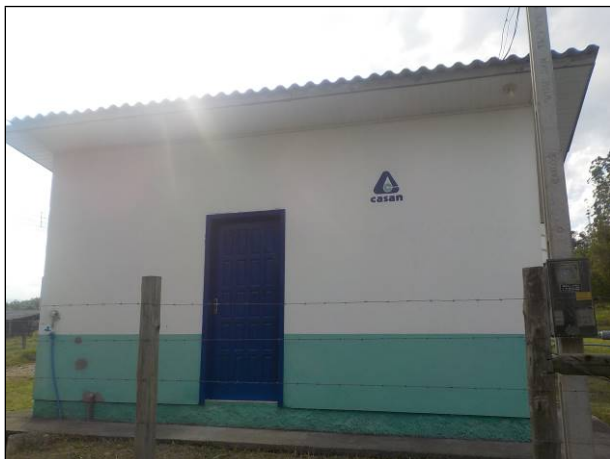
Figura 25: Edificação que comporta os equipamentos de recalque e painel de controle na ETA Vila Santa Catarina em São João do Sul.
