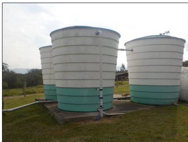
Figura 36: Vista de outro ângulo da reservação de 60 m 3 disponível para abastecimento da Vila Santa Catarina.
