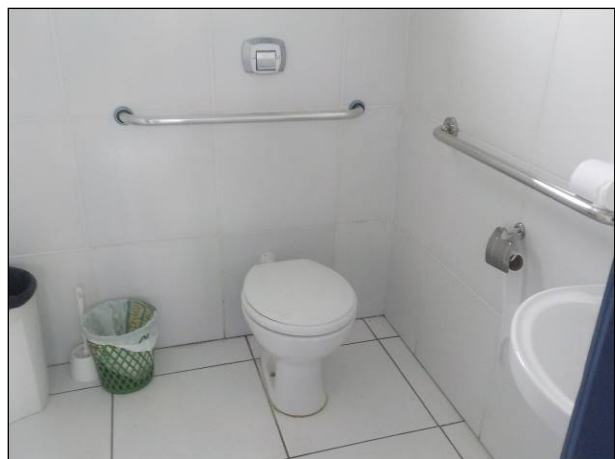
Figura 4: Vista interna do banheiro, adequado.
