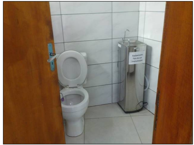
Figura 6: Vista interna do banheiro, limpo e com acesso adequado.
