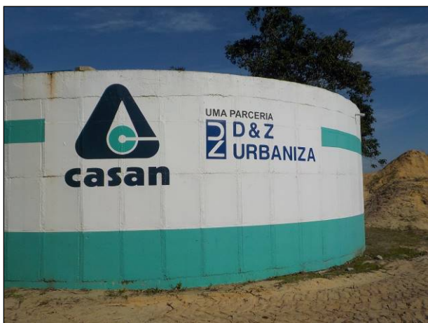
Figura 57: Vista parcial do Reservatório 04, necessária publicidade sobre sua capacidade de armazenagem interna.
