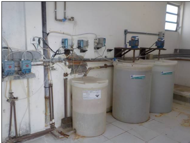
Figura 35: Armazenamento e mistura dos produtos químicos junto aos dosadores na ETA Passo de Torres.
