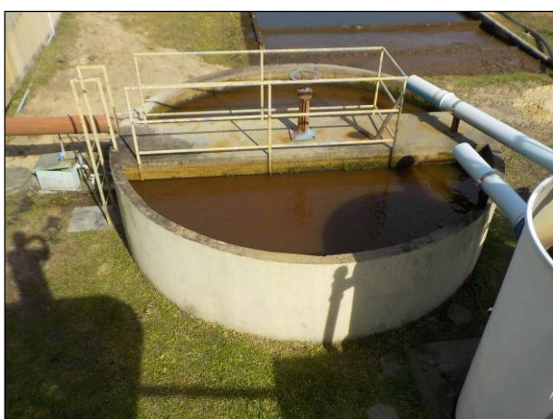
Figura 31: Vista superior de unidade de decantação pertencente ao tratamento da ETA Passo de Torres, em operação. Coloração visual da água tratada insatisfatória.
