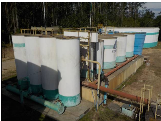
Figura 21: Vista de outro módulo (módulo II) da ETA Passo de Torres, capacidade de tratamento de 25 L/s somando-se ambos os módulos em suas capacidades máximas.
