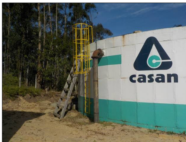
Figura 58: Vista em detalhe da escada de acesso a parte superior do Reservatório 04, condição satisfatória.
