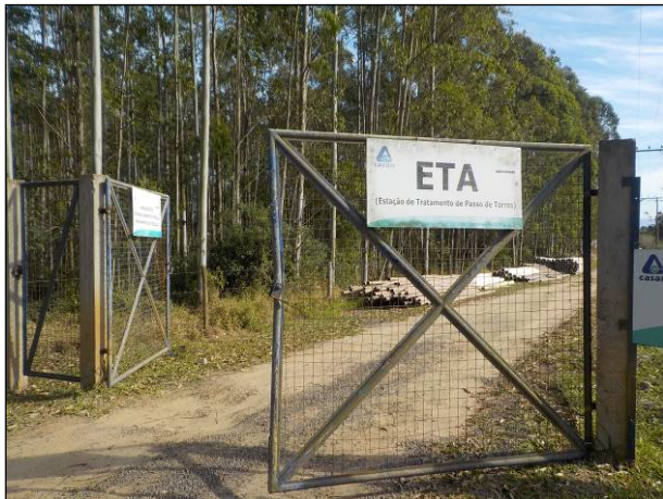
Figura 11: Portão de entrada em condições satisfatórias, restando estar trancado adequadamente. Placa indicativa adequada.
