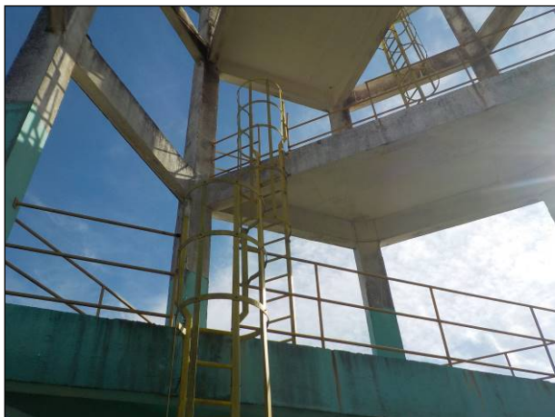
Figura 53: Detalhe das escadas e guarda-corpo para acesso à seção superior do reservatório 01, condições adequadas.
