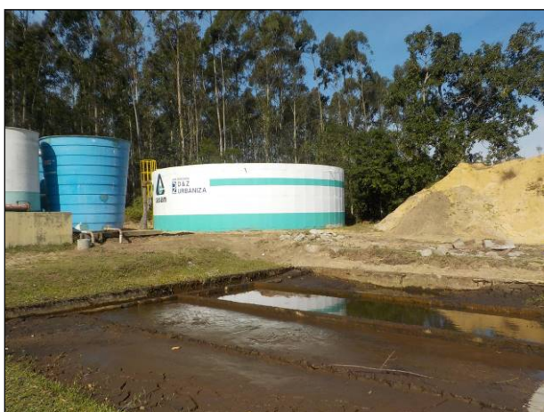
Figura 55: Vista geral do Reservatório 04, localizado junto à ETA Passo de Torres, boas condições.
