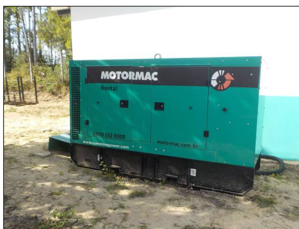
Figura 32: Equipamento para geração de energia elétrica por meio de combustível, disponível durante todo o ano para auxiliar a operação da ETA Passo de Torres.
