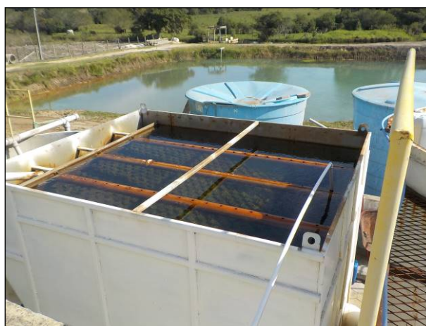
Figura 26: Estrutura para decantação da água no módulo I da ETA Passo de Torres. Boas condições.
