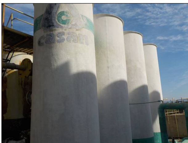
Figura 25: Vista da estrutura disponível para tratamento, etapa de filtração, sem nenhum problema aparente.
