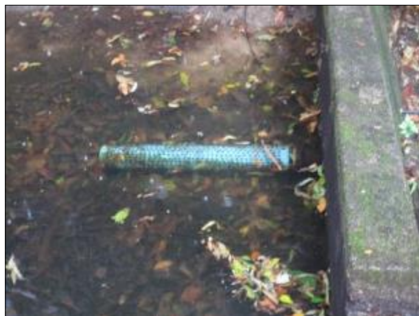
Figura 12: Detalhe do nível da água no ponto de captação com o equipamento todo submerso, captando integralmente.
