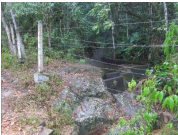
Figura 9: Vista geral da área de captação no rio Cachoeira.
