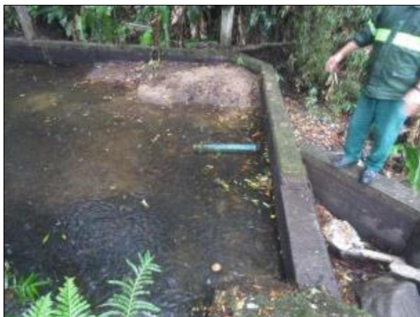
Figura 11: Vista da área de captação, com a barragem de concreto e o acúmulo de areia, indicando a estiagem.
