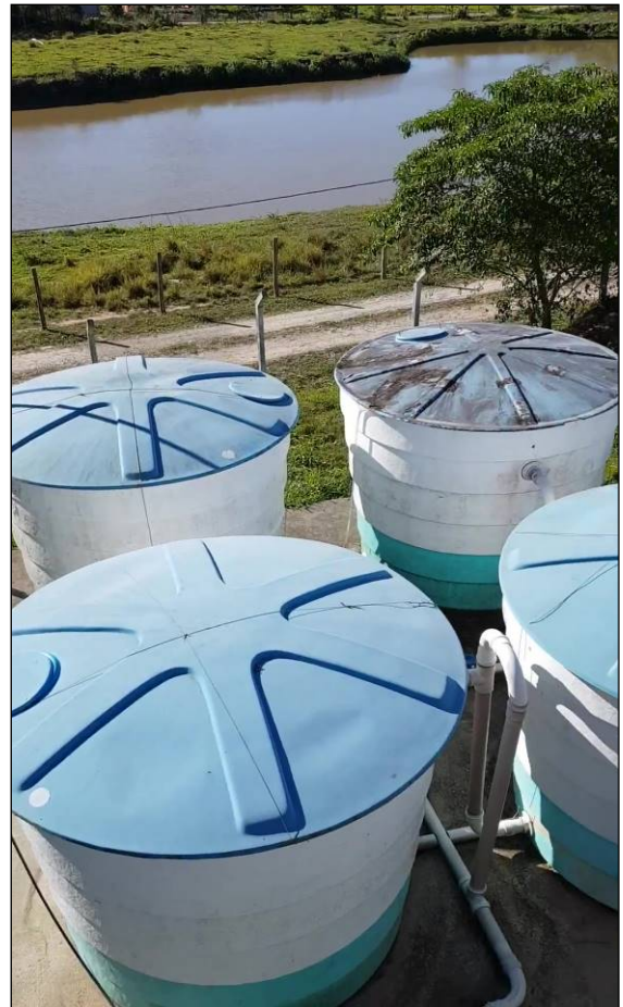
Figura 6: Vista Reservatórios ETA Morro Agudo.
