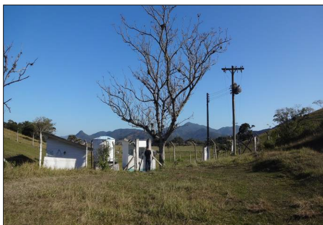
Figura 18: Vista da entrada da área de captação Sorocaba e ETA Sorocaba.
