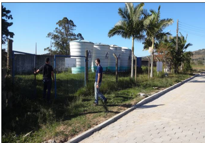
Figura 12: Vista da ETA Areias. Portão de entrada.
