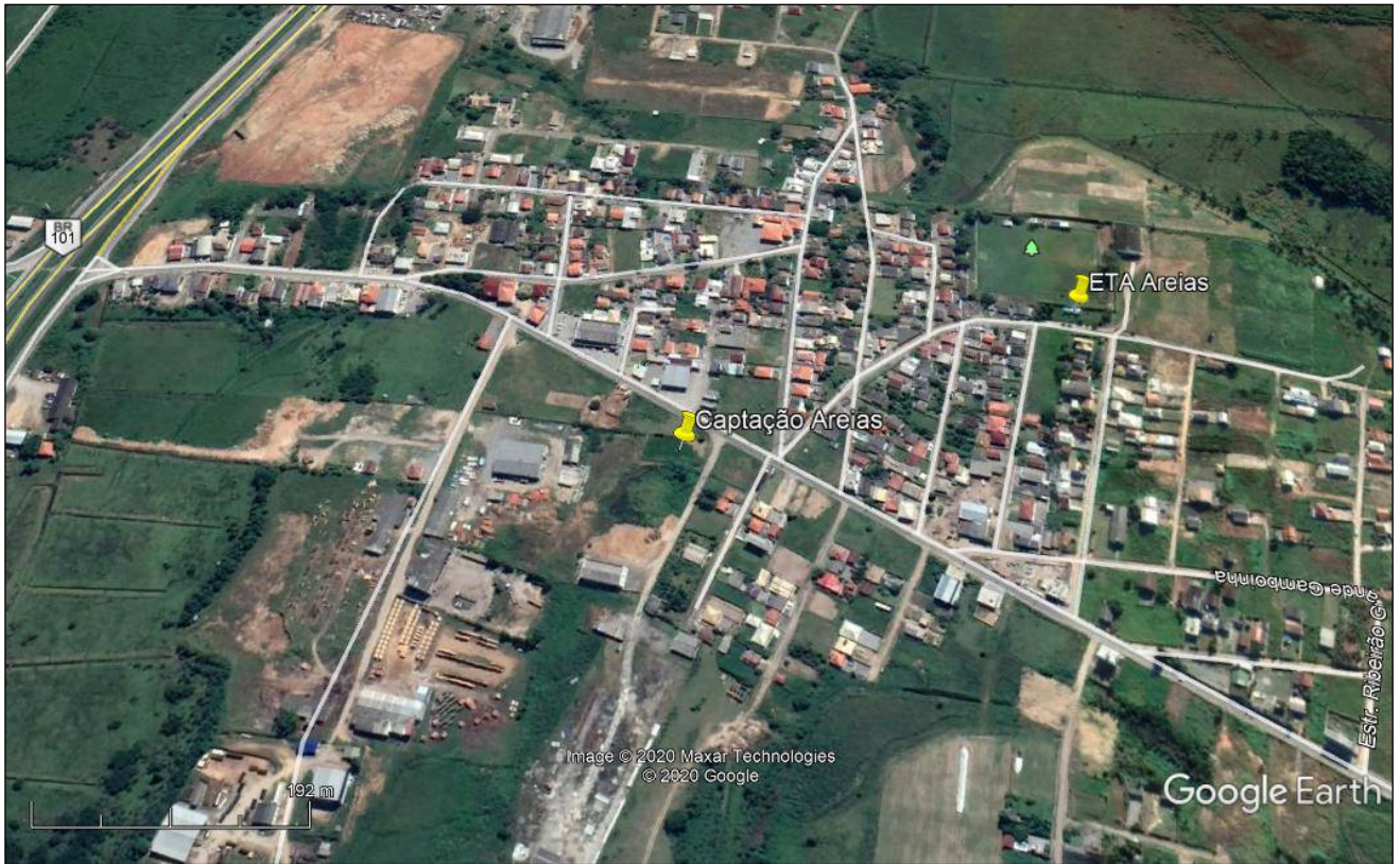
Figura 11: Localização da captação Areias e ETA Areias.
