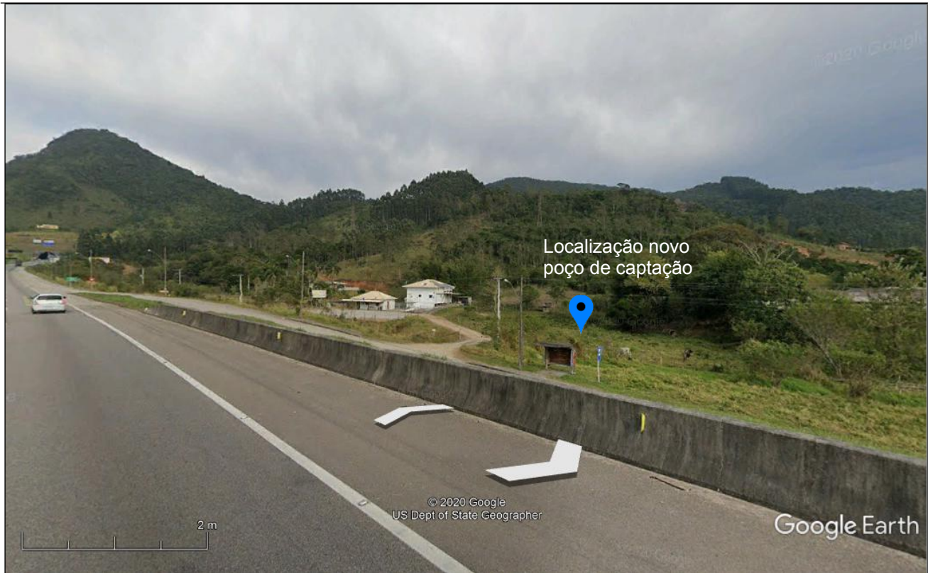
Figura 15: Vista do terreno – novo poço de captação do SAA Morro Agudo.
