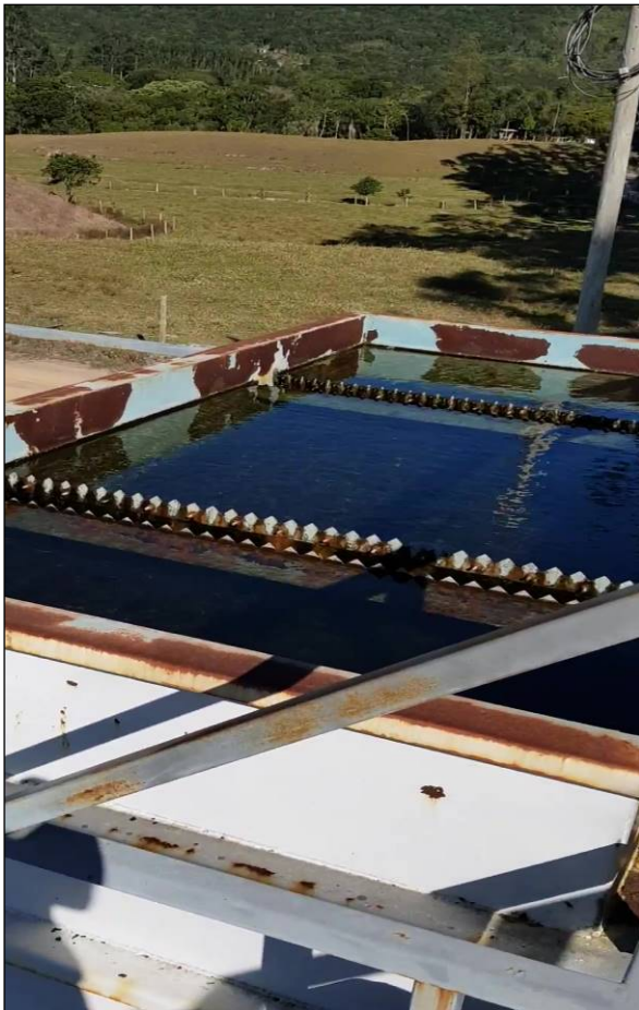
Figura 5: Vista parcial do decantador ETA Morro Agudo.
