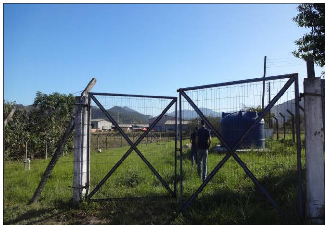
Figura 22: Vista da entrada da área de captação Areias.
