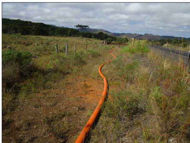
Figura 2: Uma das duas tubulações de 2 Km, para transpor o divisor de águas, que foi mantida para uso futuro, se necessário.
