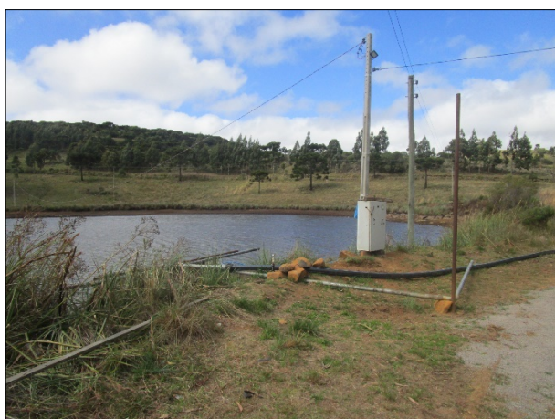
Figura 4: Vista do açude privado, em primeiro plano a estrutura elétrica ainda instalada e ao fundo o nível do reservatório,
