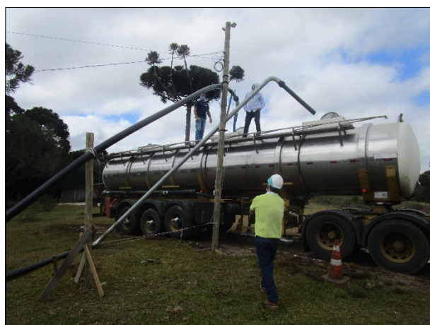
Figura 15: Estrutura montada para abastecer os caminhões-pipa com 28 m 3 de água bruta em aproximadamente 25 min.
