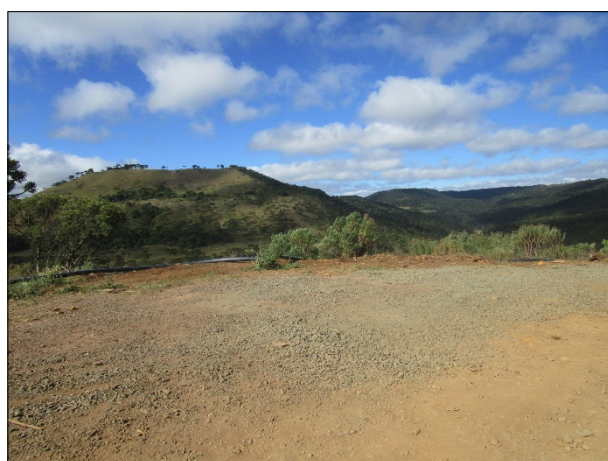
Figura 22: Área onde deve ser instalado o segundo conjunto gerador de energia elétrica, à beira da estrada vicinal de acesso e em local mais elevado do que o primeiro está previsto
