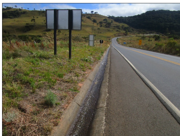
Figura 17: Ao fundo, local onde a água descartada abastecerá córrego afluente do rio Antonina, que passa sob a ponte.
