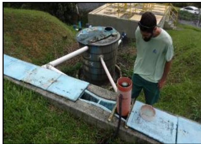
Figura 17: Medidor de vazão na calha Parshall.
