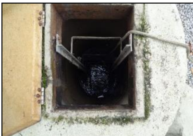
Figura 36: EEE 01. Gradeamento.
