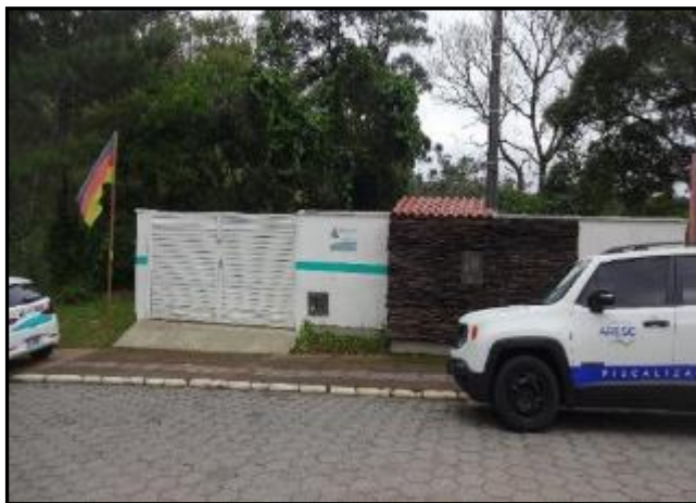
Figura 50: EEE 03. Vista geral. Identificação e cercamento.
