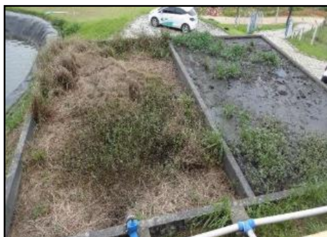
Figura 27: Leito de secagem do lodo retirado do UASB.
