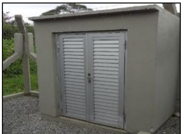
Figura 47: EEE 02. Abrigo dos quadros de comando das bombas.
