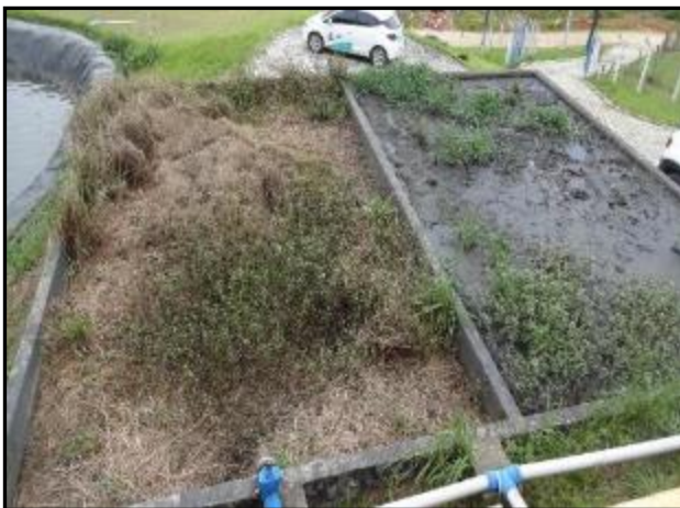
Figura 58: Leito de Secagem.
