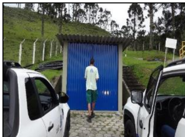
Figura 33: Casa de abrigo do quadro de comando das bombas da lagoa aerada e documentação da ETE.
