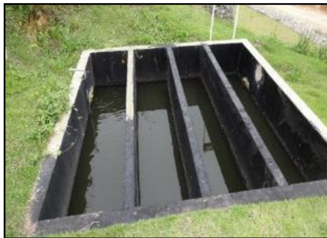
Figura 23: Desinfecção e tanque de contato.
