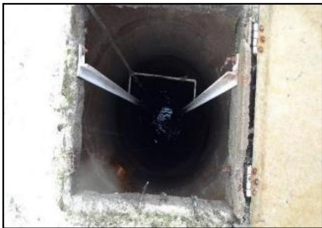
Figura 44: EEE 02. Gradeamento.
