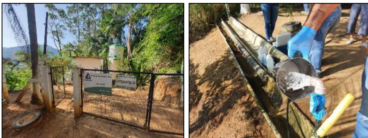
Figura 1: Visão geral da ETA de Major Gercino e coleta de amostras de água bruta (25/05/2022).
