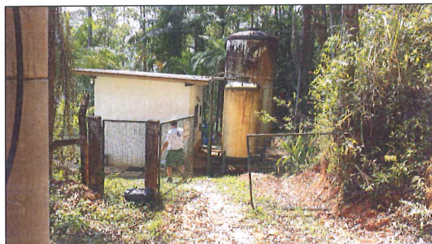
Figura 4: Estação de Tratamento de água do município de Major Gercino.
