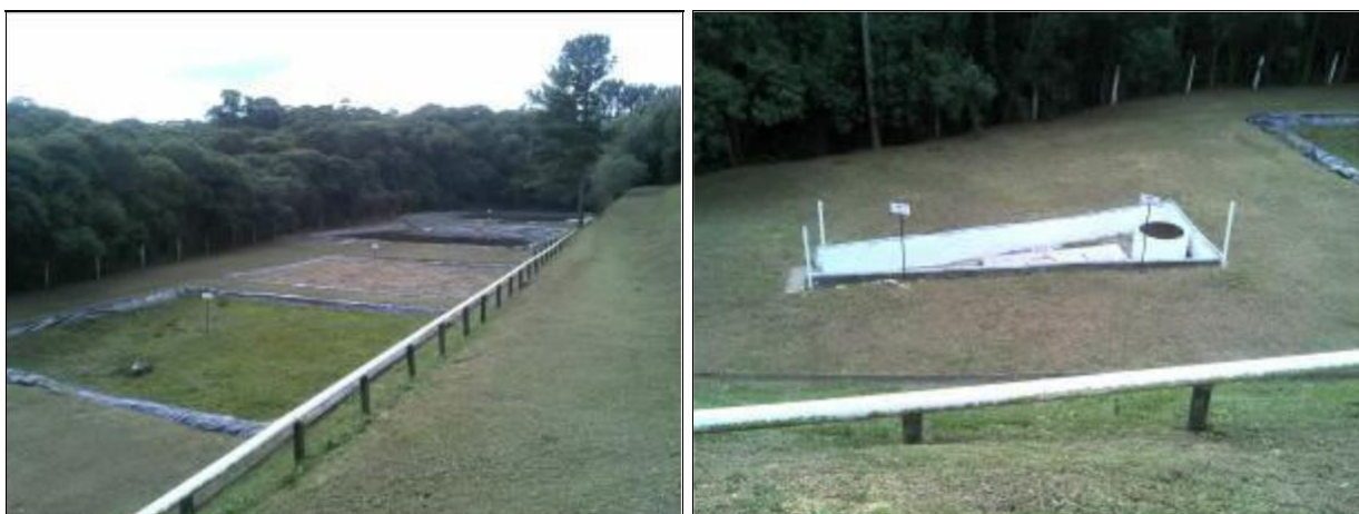
Figura 18: Tratamento de efluentes – Zona de raízes (à esquerda) e desinfecção (à direita)
