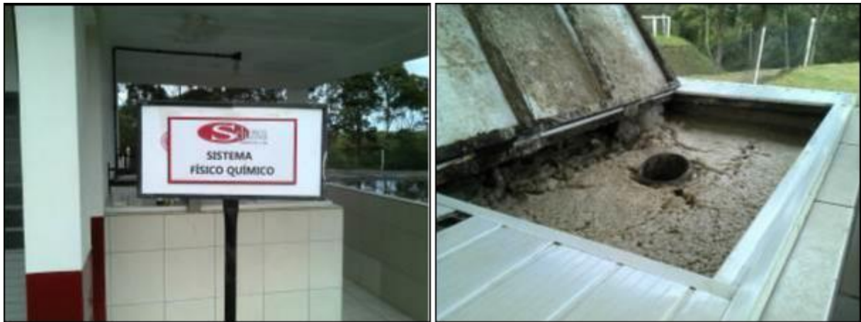
Figura 15: Tratamento de efluentes – Sistema físico-químico
