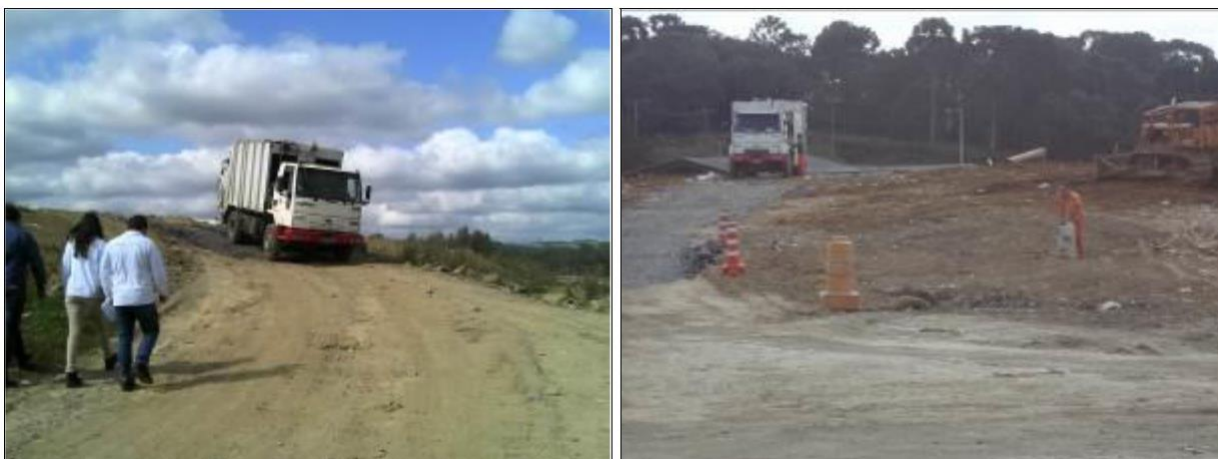
Figura 3: Caminhões e máquinas que operaram no Aterro Sanitário
