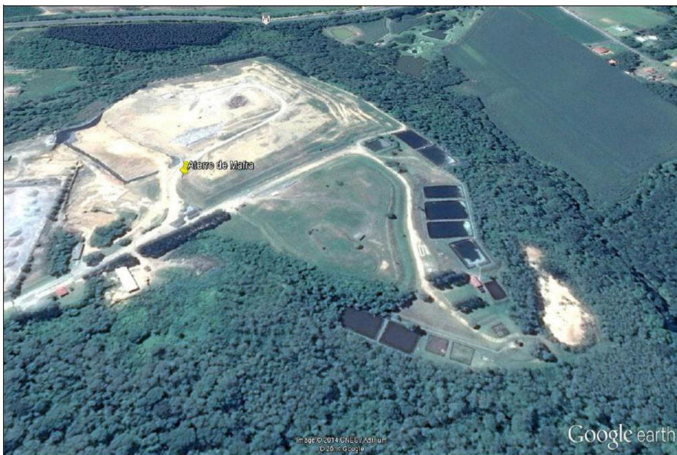
Figura 1: Vista aérea do Aterro (Fonte: Google Earth)
