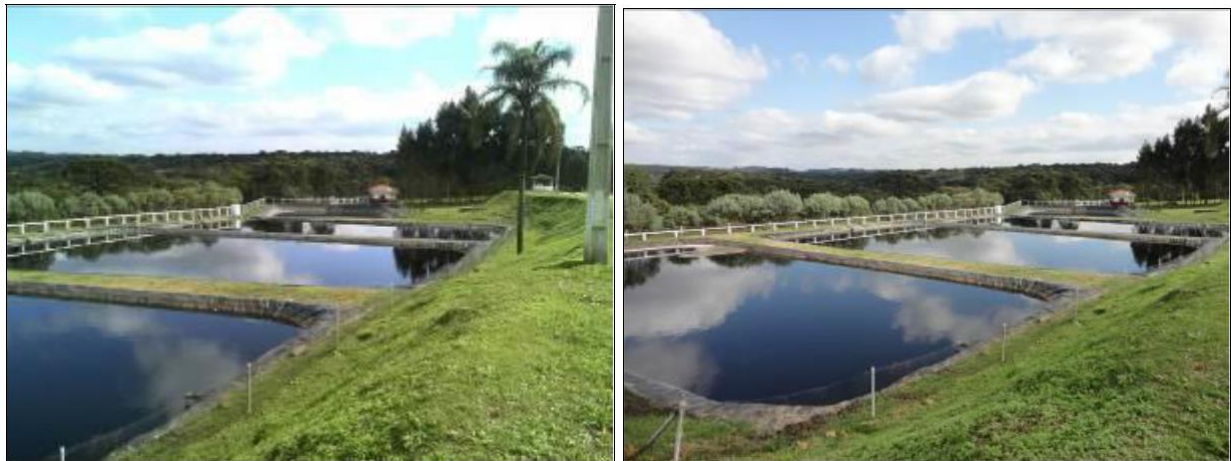
Figura 13: Tratamento de efluente – Lagoas
