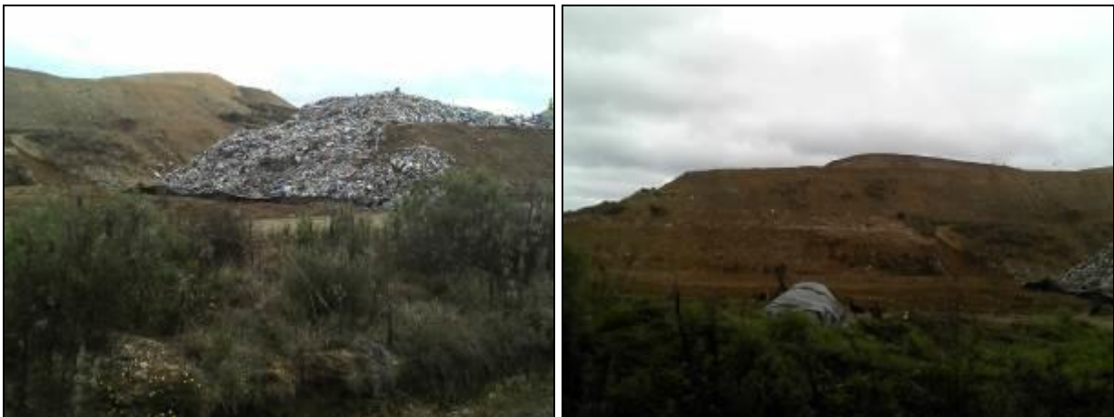
Figura 8: Área do Aterro Sanitário
