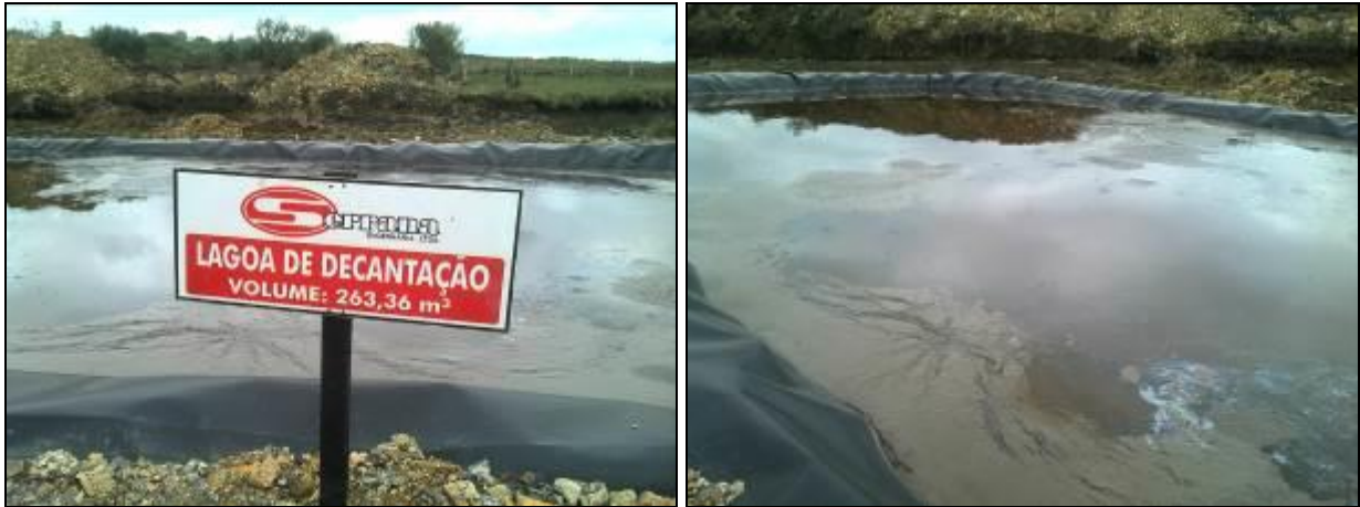
Figura 17: Lagoa de Decantação
