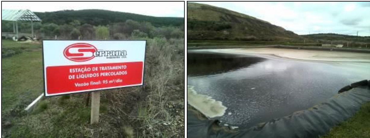
Figura 11: Estação de Tratamento de Líquidos Percolados
