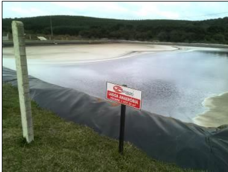
Figura 12: Lagoa Anaeróbica
