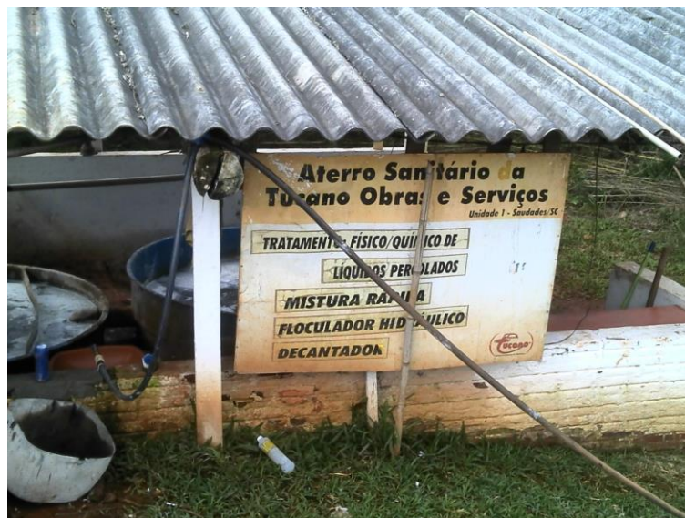
Figura 12: Sistemas de drenagem/tratamento/recalque
