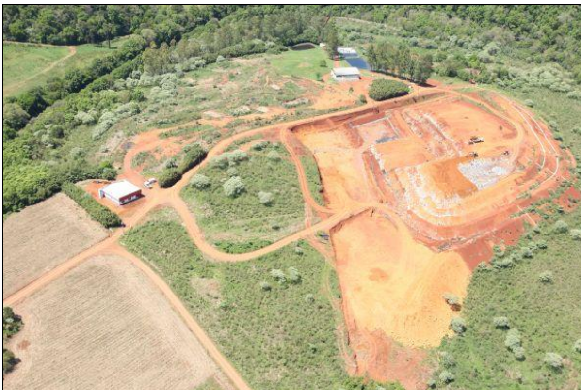
Figura 1: Vista aérea do Aterro – Unidade I (Fonte: http://grupotucano.com.br/aterros/detalhes/id/5 )
