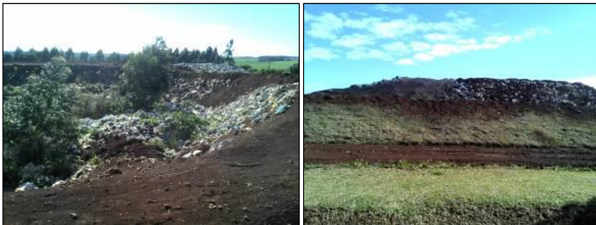
Figura 41: Área do Aterro Sanitário
