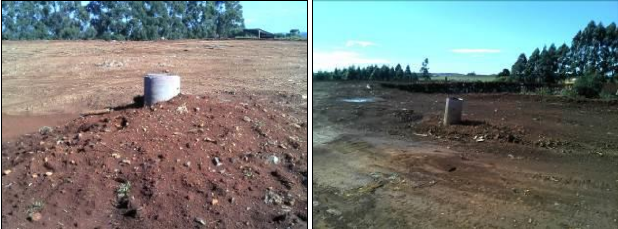
Figura 98: Queimadores de Gás no primeiro plano
