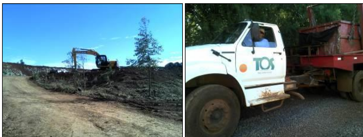
Figura 3: Máquinas e caminhões que operaram no Aterro Sanitário
