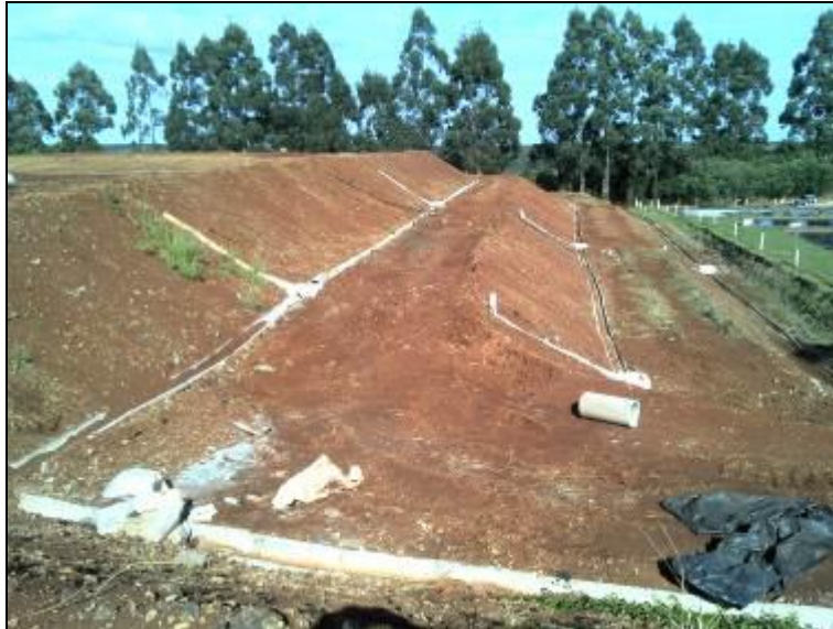
Figura 64: Drenagem de águas superficiais
