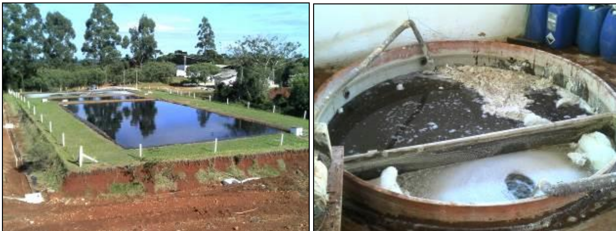
Figura 76: Sistema de tratamento
