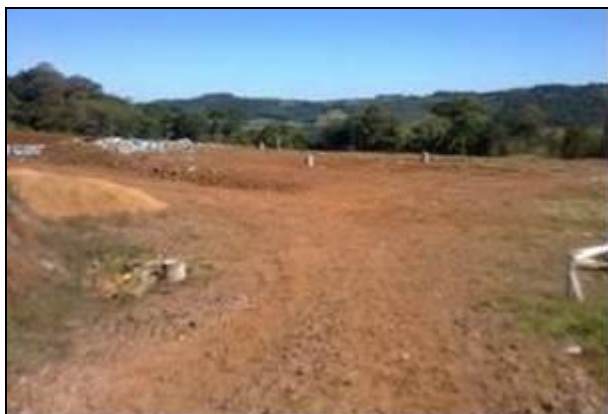
Figura 1: Vista do Aterro
