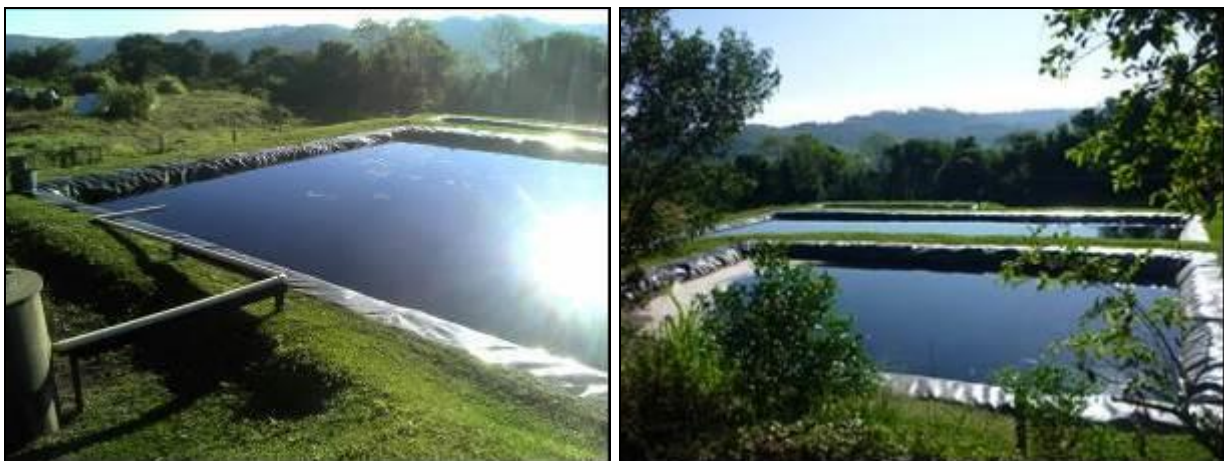
Figura 14: Sistema de tratamento
