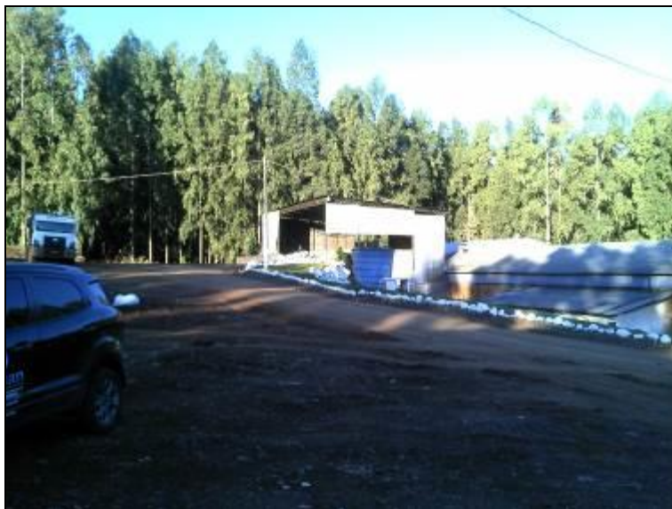
Figura 7: Galpão de triagem
