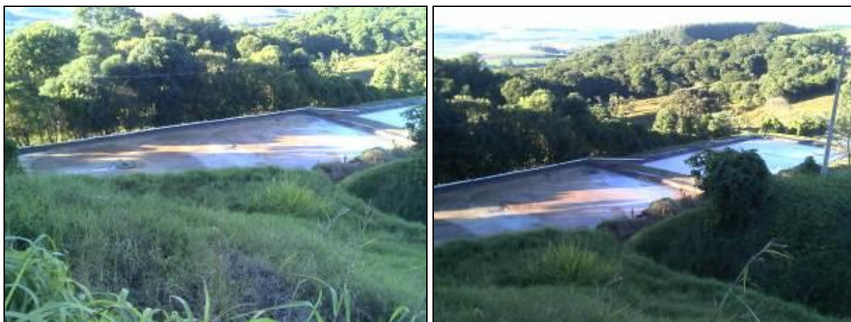
Figura 13: Sistema de tratamento
