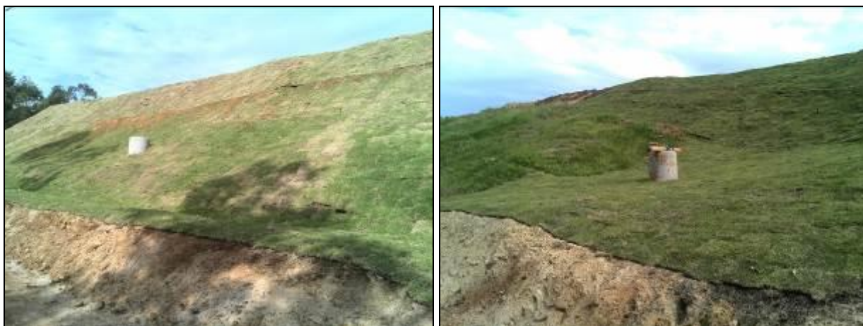
Figura 15: Queimadores de Gás no primeiro plano
