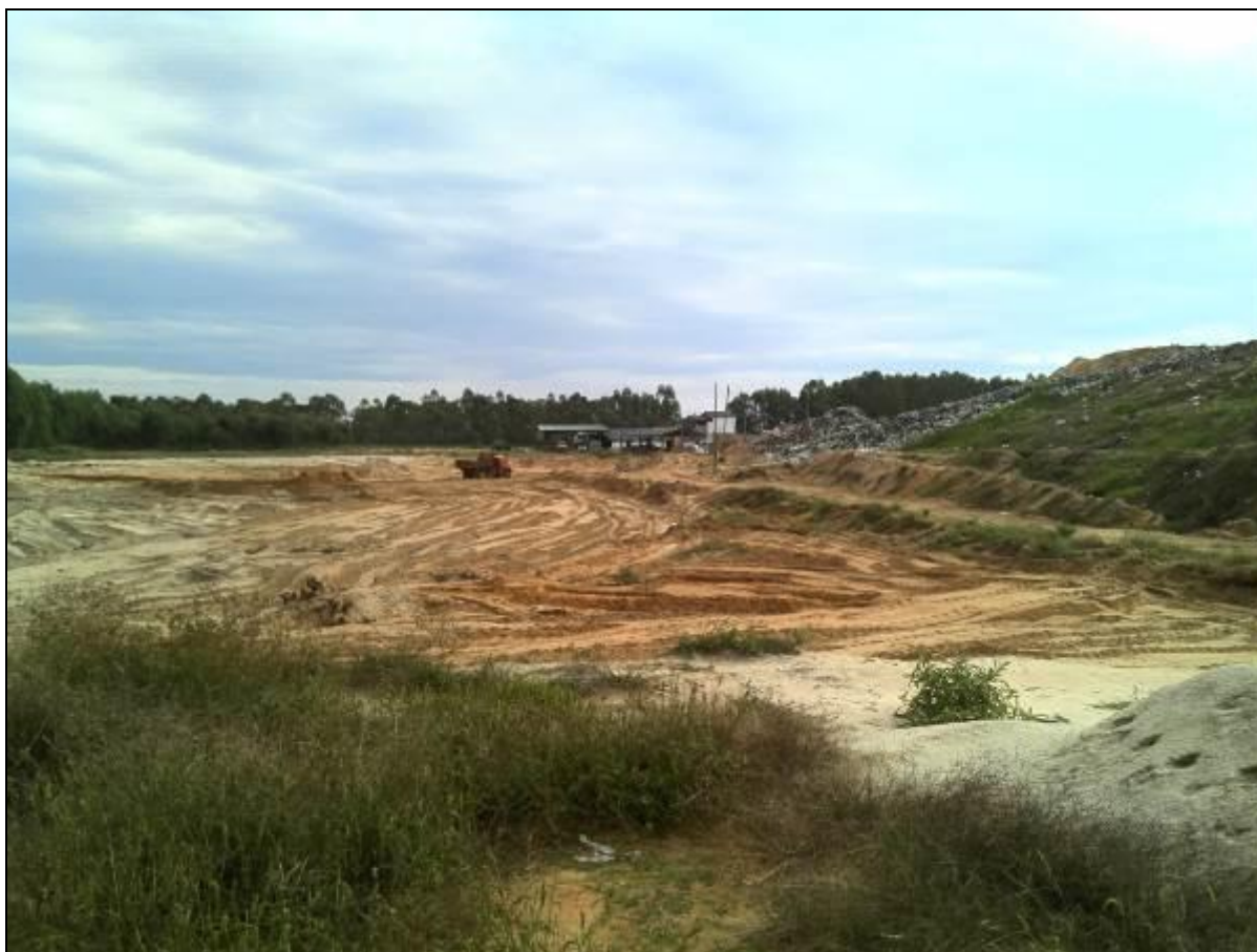
Figura 1: Vista Geral do Aterro
