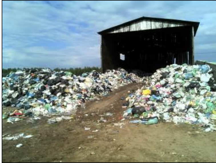
Figura 6: Galpão de triagem
