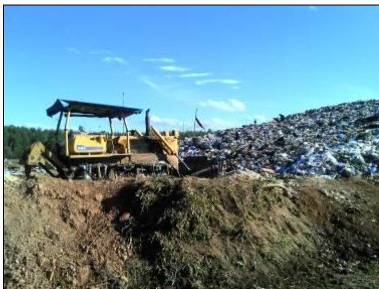
Figura 3: Máquinas que operaram no Aterro Sanitário
