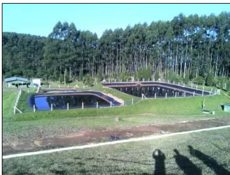
Figura 12: Sistemas de drenagem/tratamento
