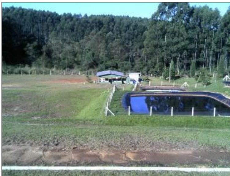
Figura 13: Sistema de tratamento
