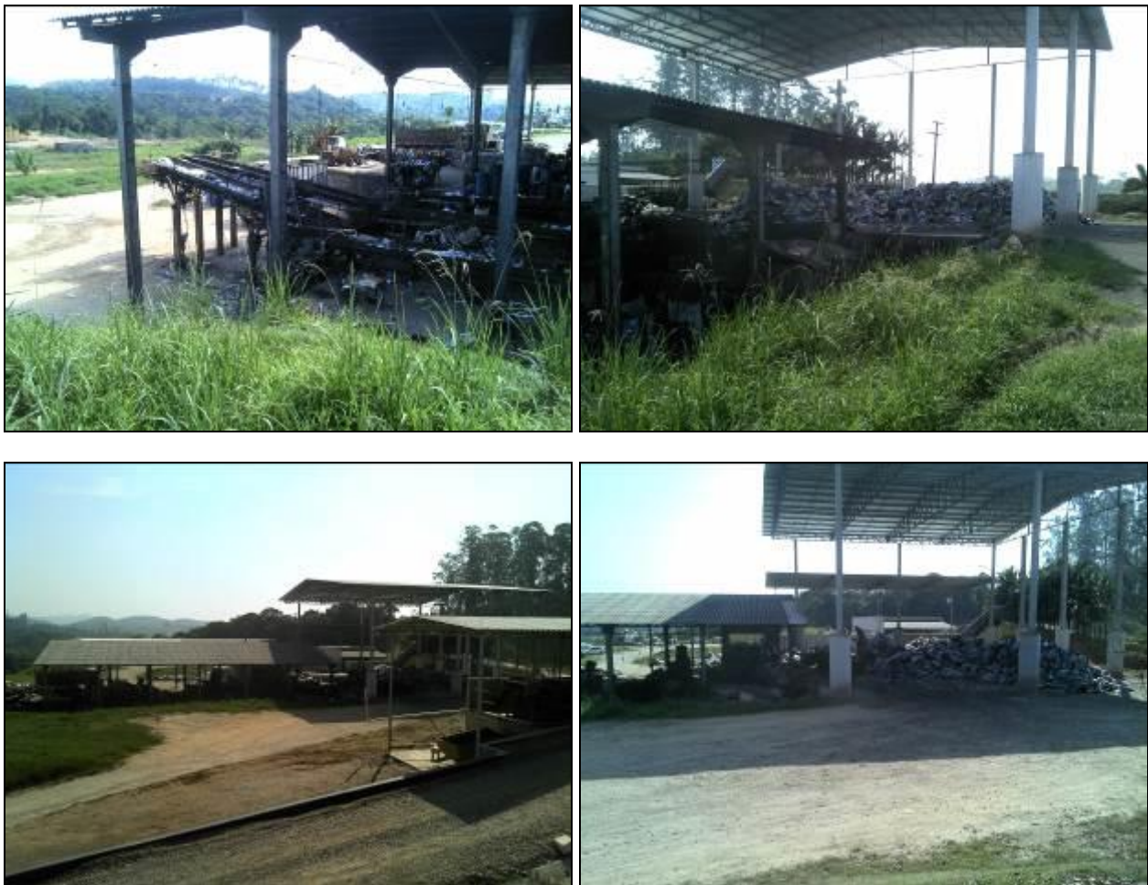
Figura 8: Galpão de triagem
