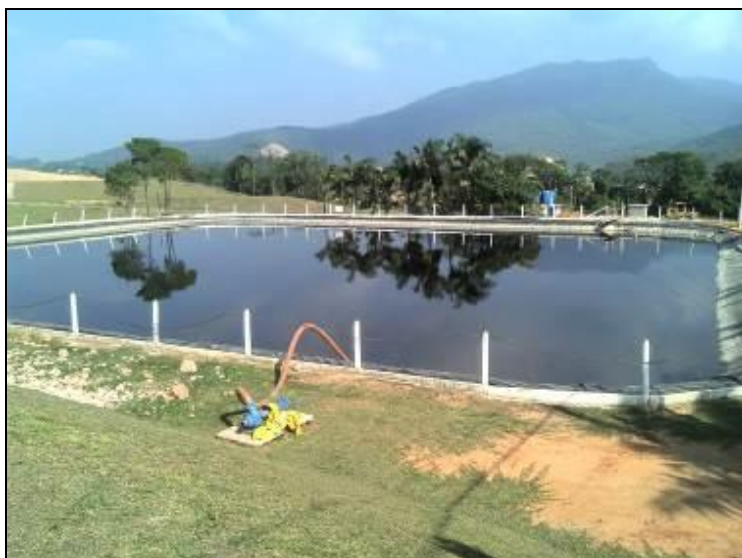
Figura 13: Sistemas de drenagem/tratamento
