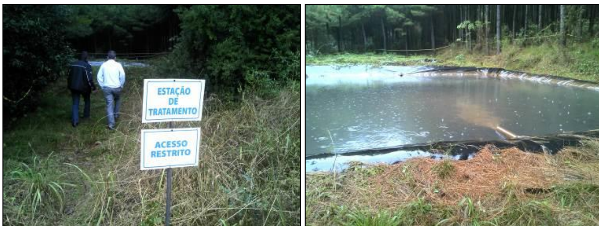
Figura 10: Sistemas de drenagem e tratamento em Videira/SC
