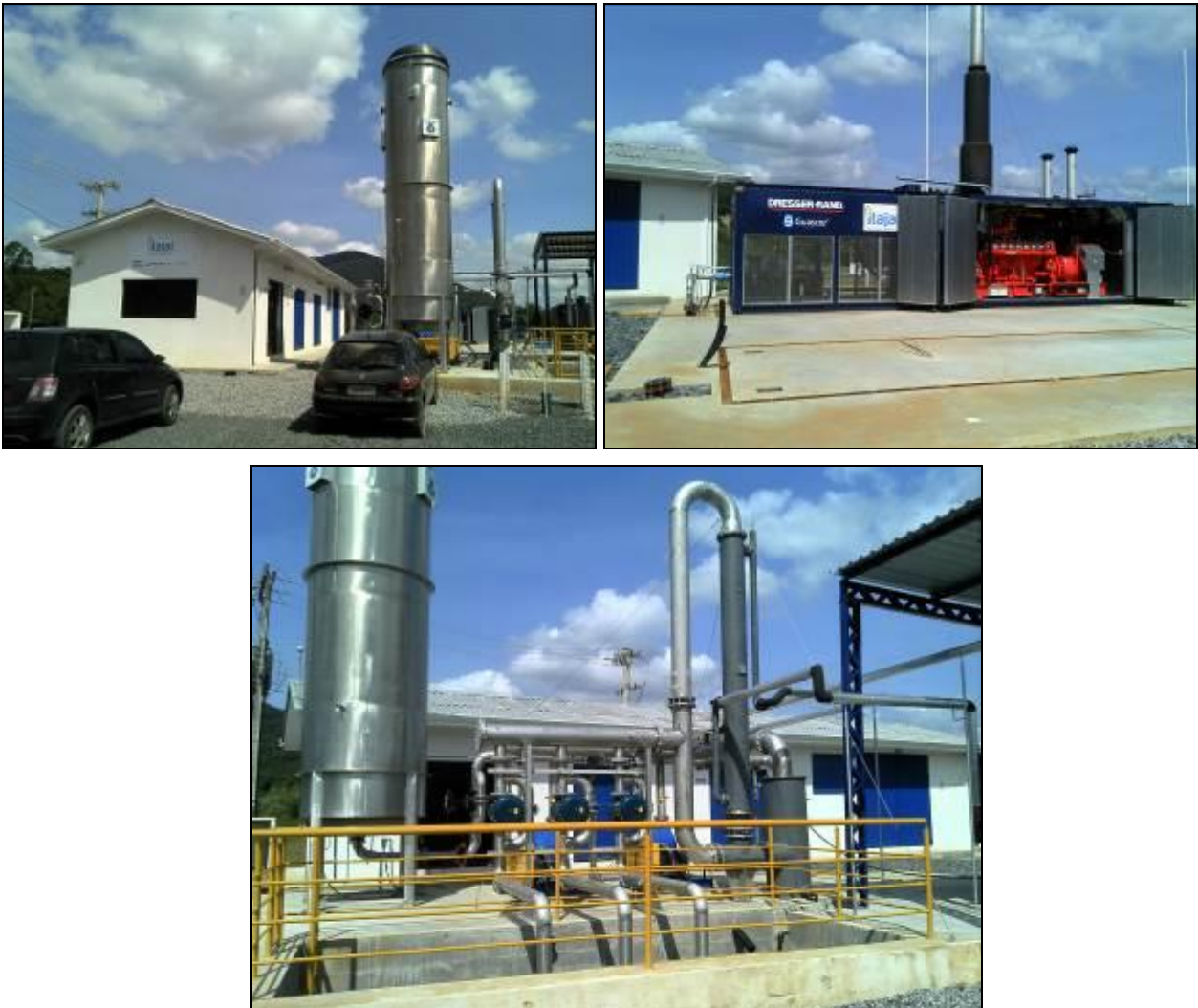
Figura 15: Queimadores de Gás no primeiro plano
