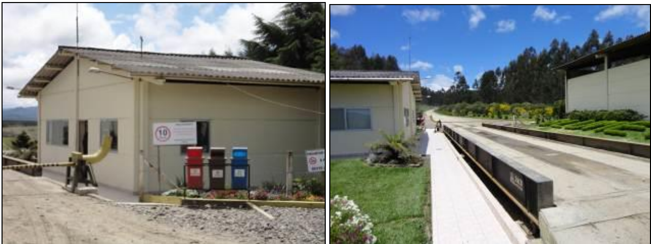
Imagens da área frontal do Aterro Sanitário.
