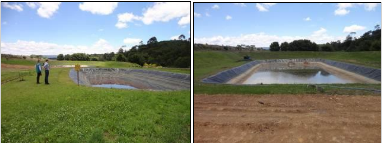
Lagoas de coleta de chorume que posteriormente são encaminhados à Estação de Tratamento da Klabin.
