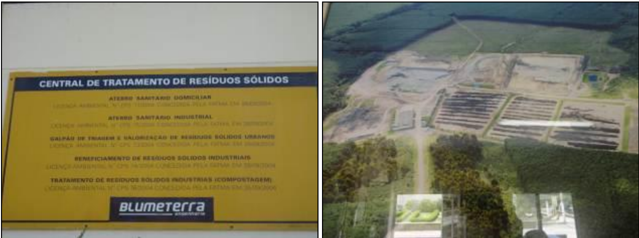
Placa de identificação e vista aérea geral do Aterro Sanitário.
