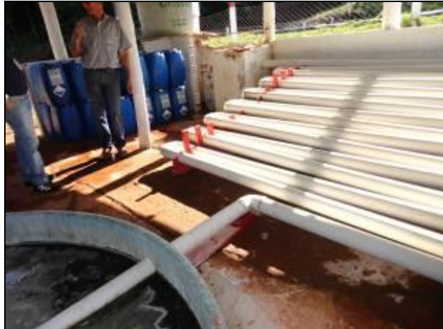
Processo de tratamento do chorume após decantação nas lagoas.
