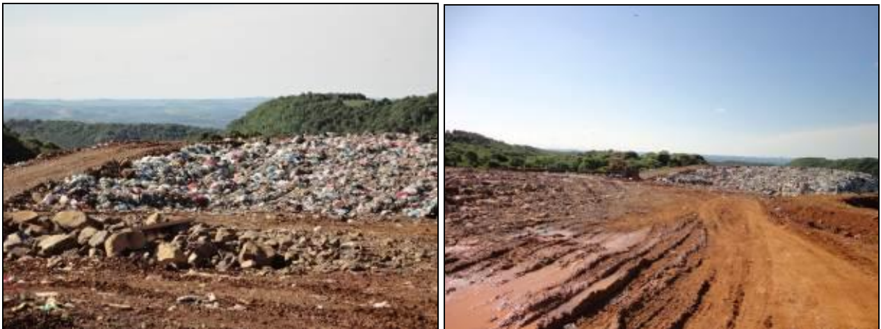
Imagens do Aterro Sanitário da TUCANO em Erval Velho.
