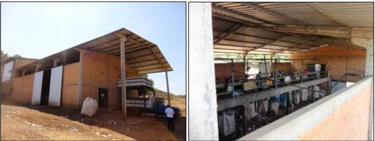
Vistas gerais do galpão de triagem
