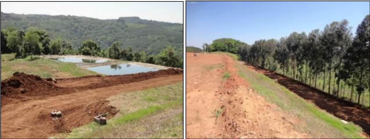
Vista das lagoas de tratamento de efluentes e lateral do Aterro protegida por eucaliptos.
