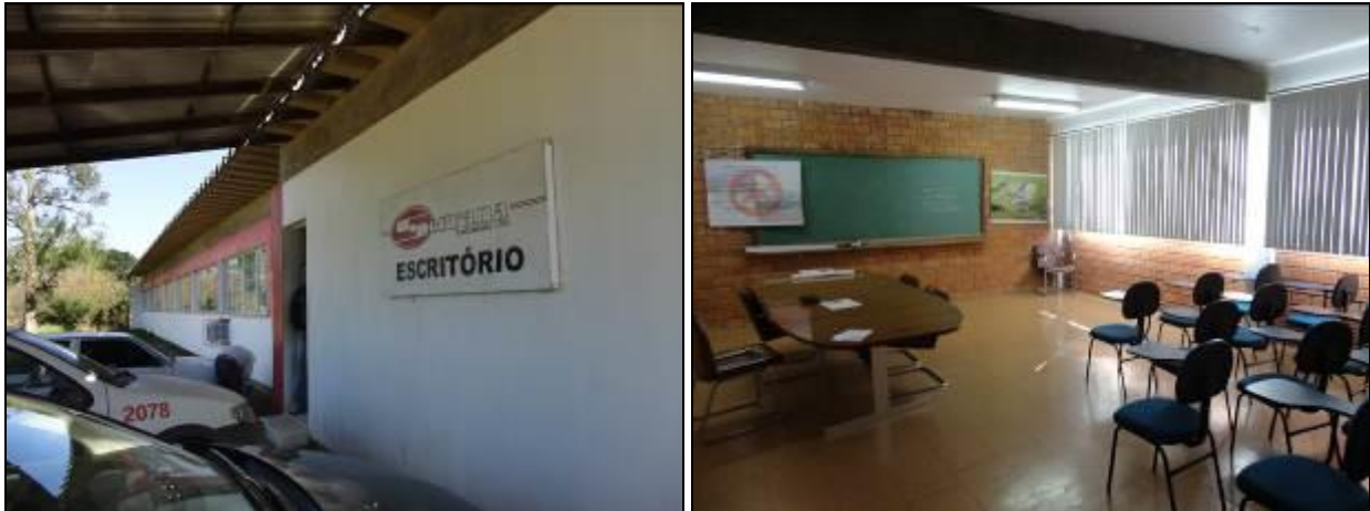
Fachada frontal do Escritório e auditório.
