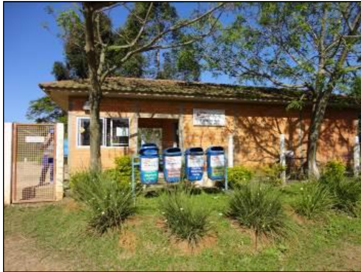
Parte da fachada e entrada principal do Aterro Sanitário
