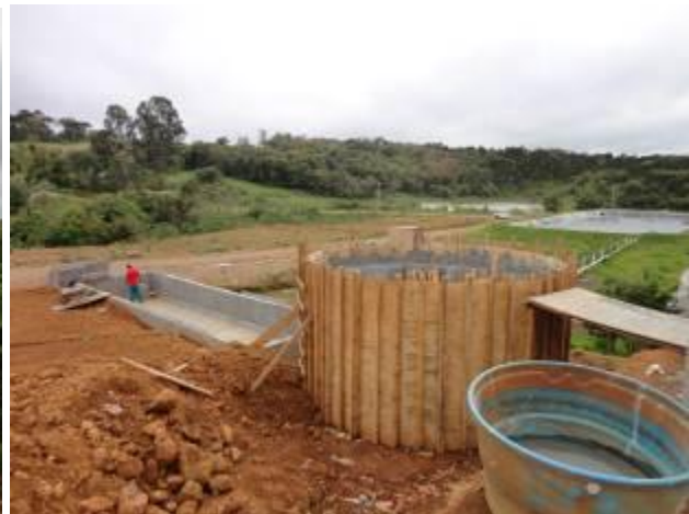
Lagoas de tratamento de chorume (esquerda) e Sistema de recepção e tratamento de matérias de fossas, em construção (direita).
