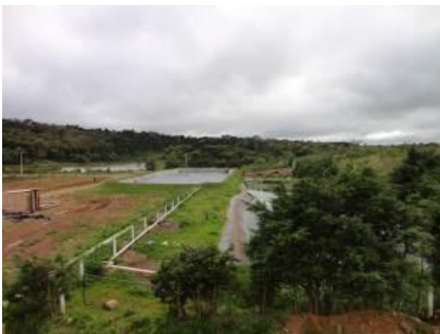
Lagoas de tratamento de chorume (esquerda) e Sistema de recepção e tratamento de matérias de fossas, em construção (direita).
