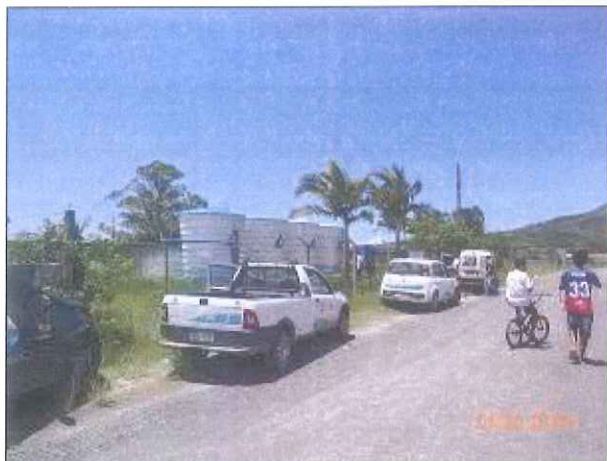
Figura 9: Unidade de Tratamento Areias – município de Paulo Lopes.
