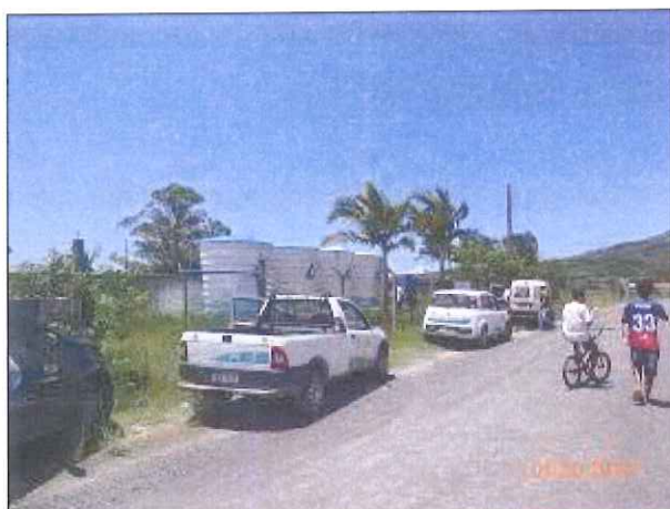
Figura 3: Unidade de tratamento Areias - município de Paulo Lopes.
