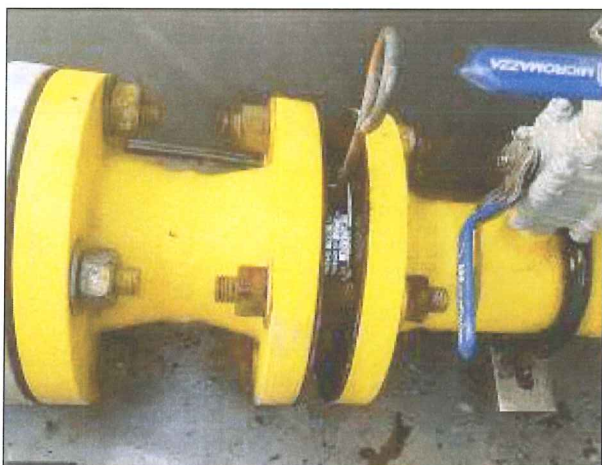
Figura 07 - Parafusos e porcas com ferrugem.
