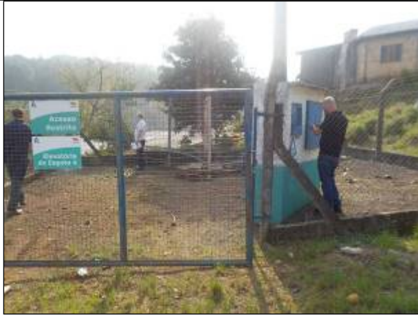
Figura 139: Vista da entrada da EEE 04 com as placas de restrição de acesso e indicação da unidade afixadas no portão.
