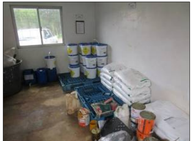
Figura 48: Vista interna da área destinada a armazenar os produtos químicos utilizados no tratamento da água na ETA Catanduvás; todos sobre piso plástico elevado.
