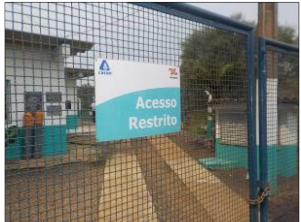
Figura 36: Placa de restrição de acesso no portão de acesso de carros da ETA Catanduvas.
