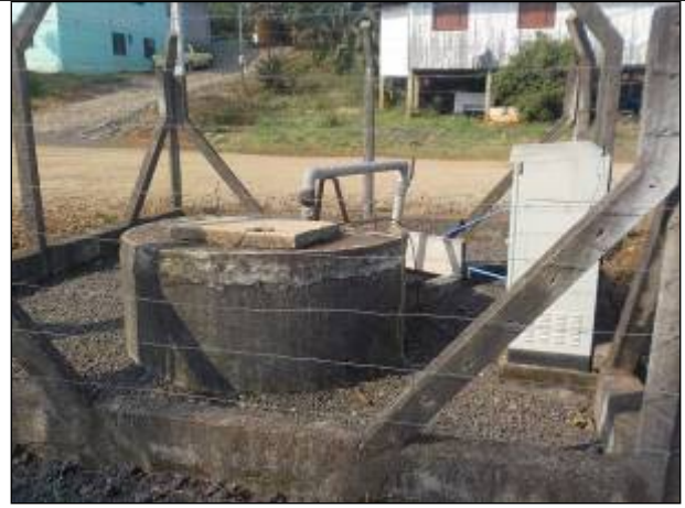
Figura 146: Vista parcial da área cercada da EEE 05, localizada no Centro oeste.
