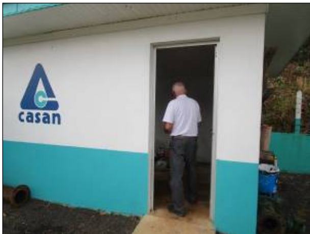
Figura 47: Vista externa da área destinada a armazenar os produtos químicos utilizados no tratamento da água na ETA Catanduvás.
