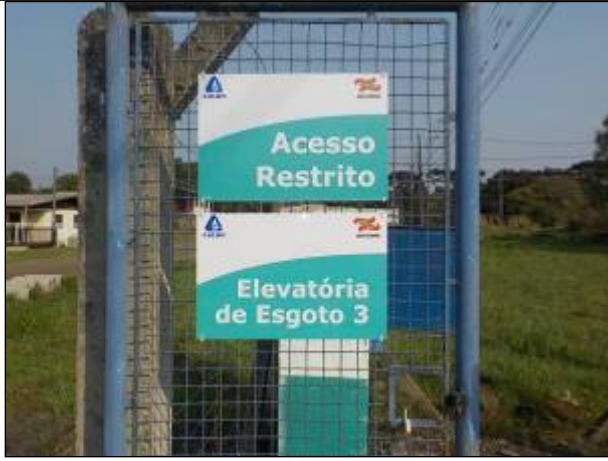
Figura 133: Vista das placas indicativas da unidade e de restrição de acesso afixadas no portão de entrada da EEE 03.
