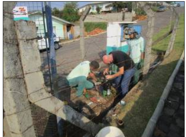
Figura 132: Trabalho de troca da bomba na EEE 02, novo equipamento com a mesma potência.
