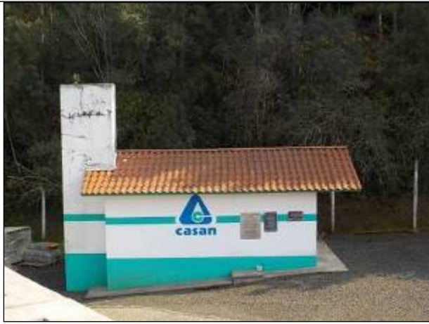
Figura 115: Vista do imóvel onde localizam-se os painéis de controle, os documentos e o laboratório da ETE.
