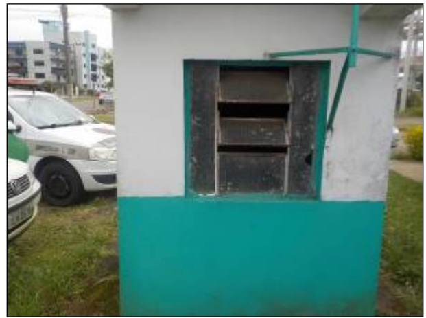
Figura 34: Vista da área externa, fundos, do local onde o Painel de Controle está localizado.
