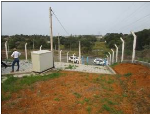
Figura 89: Vista da entrada de pedestres do reservatório Casagrande, ainda não ativado.
