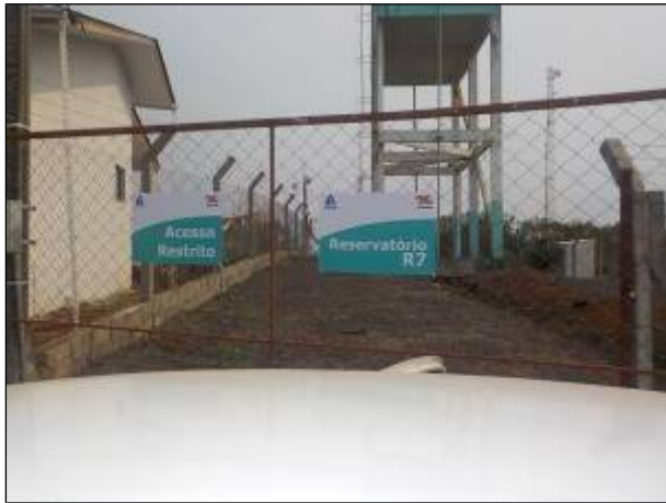
Figura 81: Vista do portão de acesso do R-07, no Condomínio Moradas do Sol, contendo as placas indicativas e restritivas ao local.
