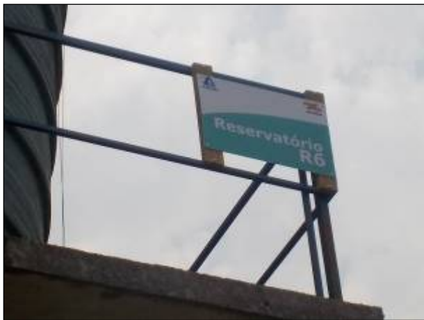
Figura 77: Detalhe da placa indicativa do reservatório R-06 (Covalan), afixada na parte superior lateral da estrutura.
