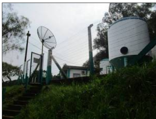
Figura 22: Vista da ETA a partir da escada de acesso à Área de Captação do Lajeado Catanduvras.
