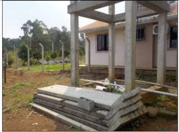
Figura 80: Detalhe dos palanques curvos que serão o suporte do cercamento futuro da área do R-06; ao fundo os mourões de concreto já estão fixados, restando a cerca metalizada para isolar a área e manter a segurança do local.
