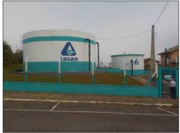
Figura 70: Vista frontal da área cercada onde estão localizados os reservatórios R-03, à frente, e R-01 (desativado), ao fundo.
