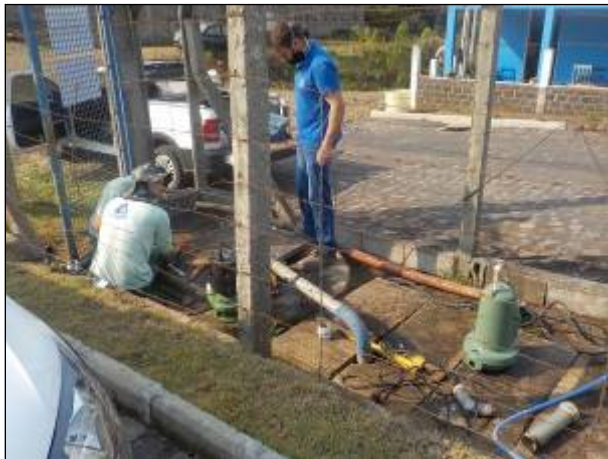
Figura 131: Trabalho de troca da bomba na EEE 02, equipe de manutenção em atividade.
