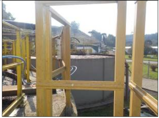
Figura 104: Vista dos tanques aeradores dispostos lado a lado.
