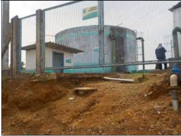
Figura 61: Portões de acesso às áreas da ERAT 03 e reservatórios R-02 e R-04.
