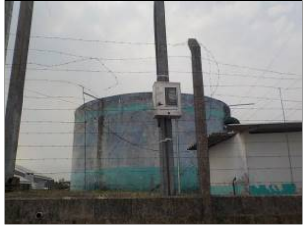
Figura 62: Detalhe do cercamento da área e do medidor de energia elétrica, ao fundo o reservatório R-02
