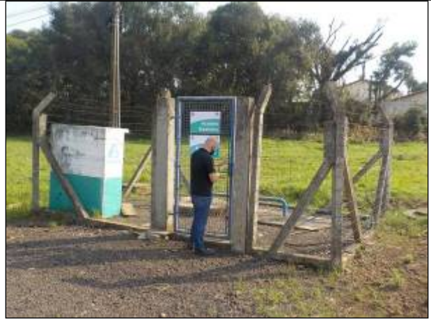
Figura 134: Vista geral da área onde está localizada a EEE 03, local cercado e trancado, portanto protegido.
