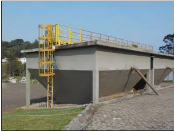
Figura 107: Vista parcial do local onde é realizada a decantação secundária, com destaque para a escada e passarela de acesso.
