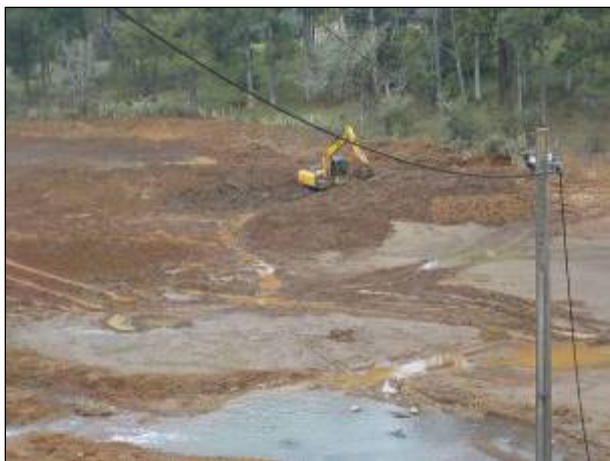
Figura 23: Maquinário fazendo a dragagem da barragem do Lajeado Catanduvras.
