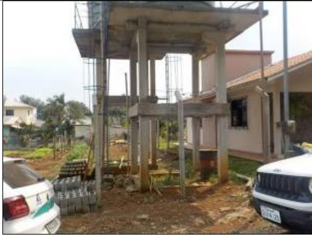
Figura 79: Vista frontal da estrutura construída para elevar os reservatórios componentes do R-06; no solo estão os materiais para finalização da construção e à frente pode-se observar os postes que serão a estrutura do cercamento futuro.
