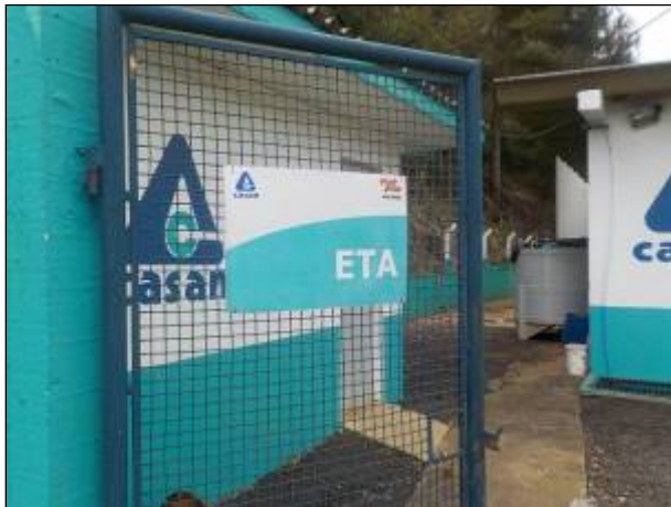
Figura 35: Placa indicativa da unidade no portão de acesso de pedestres da ETA Catanduvas.
