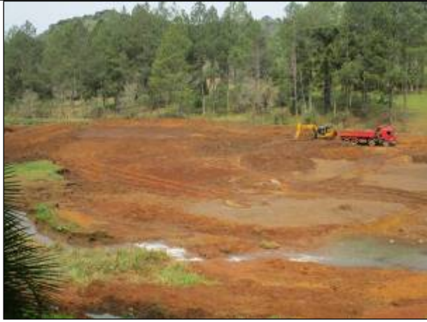
Figura 25: Maquinário realizando a dragagem da barragem do Lajeado Catanduvras.
