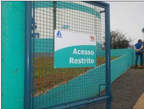
Figura 71: Detalhe da placa indicativa de acesso restrito às unidades.
