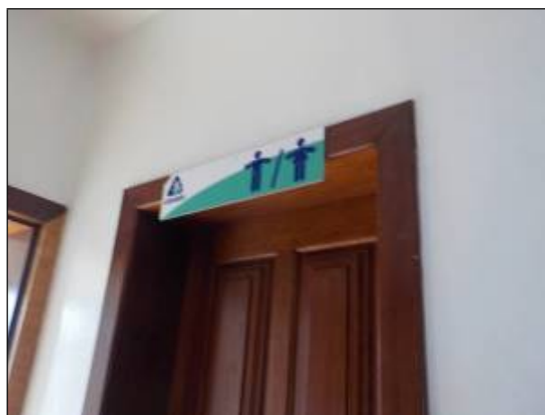
Figura 6: Placa informativa do banheiro compartilhado, seu interior em boas condições.
