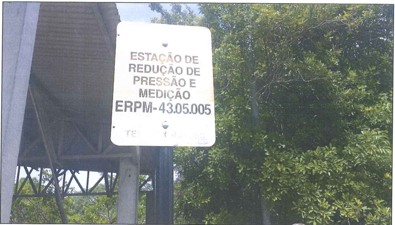
Figura 1: Placa de identificação com telefone da SCGAS ilegível
