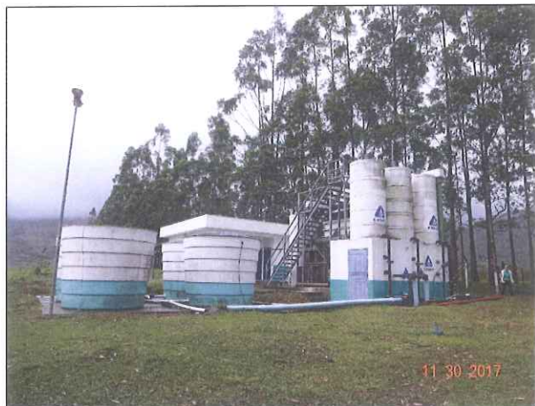
Figura 21: ETA Morro Agudo
