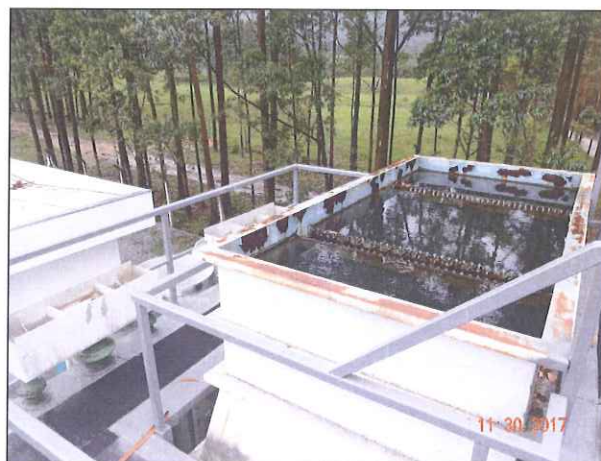
Figura 17: ETA Morro Agudo
