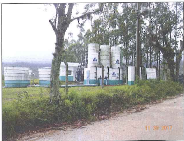
Figura 13: ETA Morro Agudo
