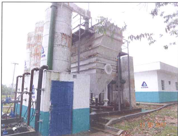
Figura 16: ETA Morro Agudo
