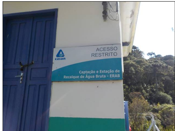
Figura 16: Vista da placa indicativa da ERAB afixada na parte externa da edificação onde estão localizadas as bombas e o painel de controle.
