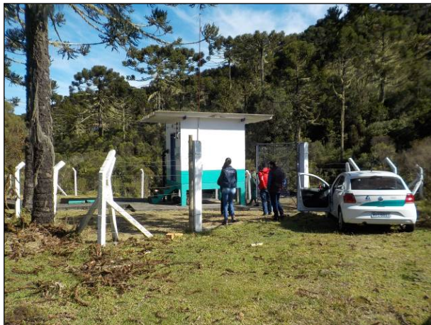
Figura 15: Vista da ERAB, junto ao rio Baú, cercada adequadamente e com a pintura padrão da concessionária.
