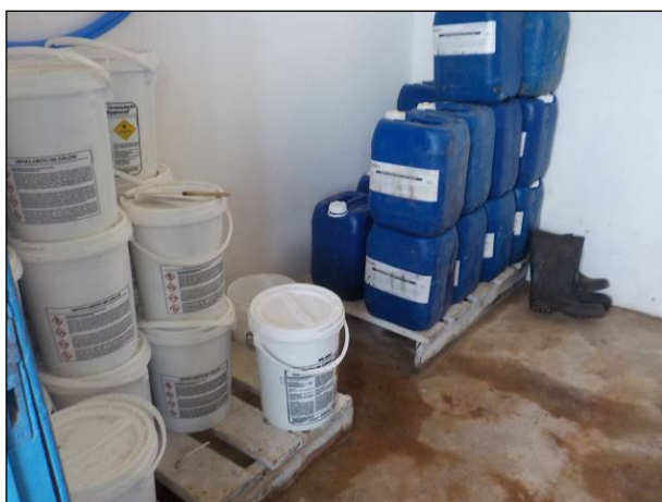
Figura 31: Vista dos produtos químicos disponíveis na ETA, para tratamento, depositados adequadamente sobre páletes.
