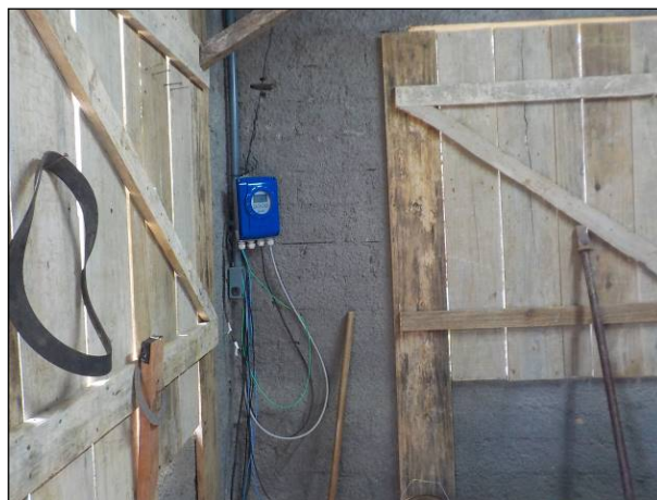
Figura 30: Vista da área interna da edificação (em obras) onde está localizado o equipamento de dosagem de produtos químicos.
