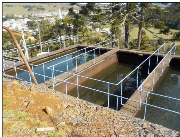
Figura 26: Vista dos filtros lentos, posteriormente serão transformados em reservatórios (230 m 3 ).
