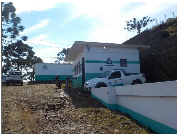
Figura 33: Vista do local, na ETA, onde estão dispostos os equipamentos de laboratório.
