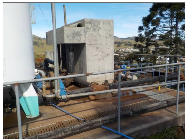
Figura 20: Vista das obras de conclusão da nova ETA em andamento.
