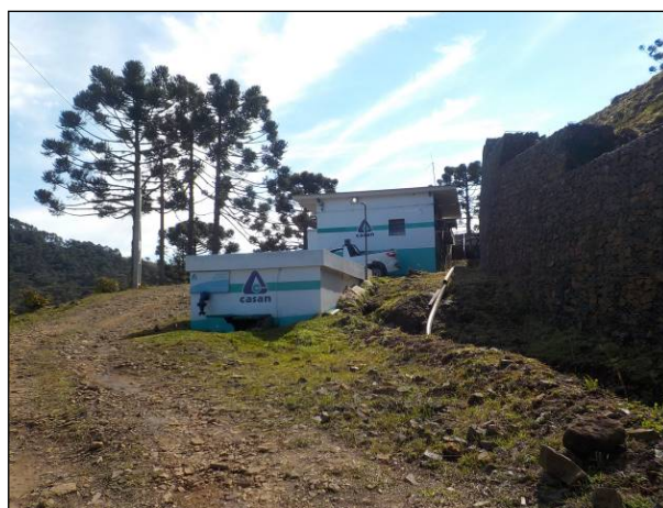
Figura 38: Vista do acesso à ETA, a partir de seu portão de entrada, em primeiro plano o reservatório R1.
