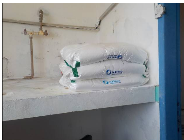
Figura 32: Vista dos produtos químicos disponíveis na ETA, adequadamente armazenados.
