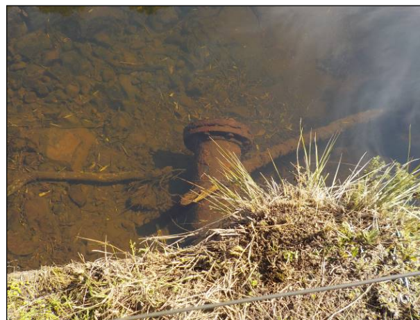
Figura 14: Vista do local de captação na barragem do rio Baú.
