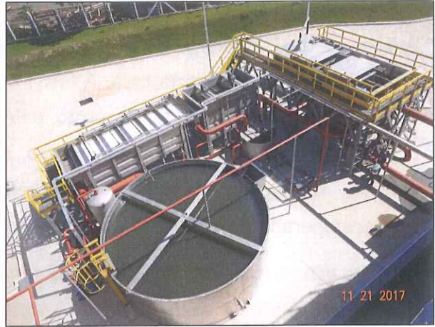
Figura 10: Vista superior – Tratamento preliminar, físico-químico e tanque de contato.
