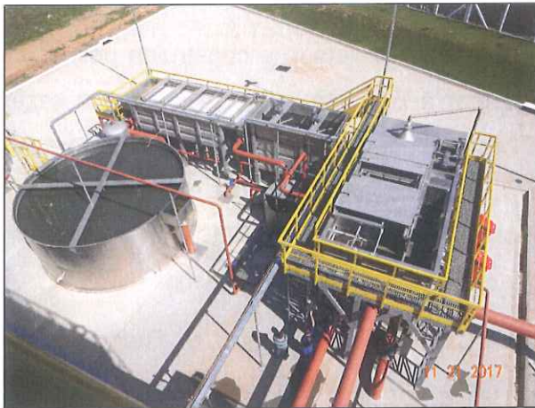
Figura 10: Vista superior – Tratamento preliminar, físico-químico e tanque de contato.
