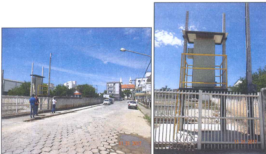
Figura 6: Quadro de comando e energia da EEE C2.
