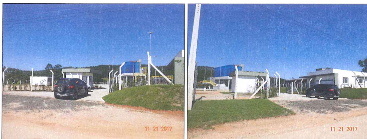
Figura 8: ETE Braço do Norte – Unidade sem placa de identificação.
