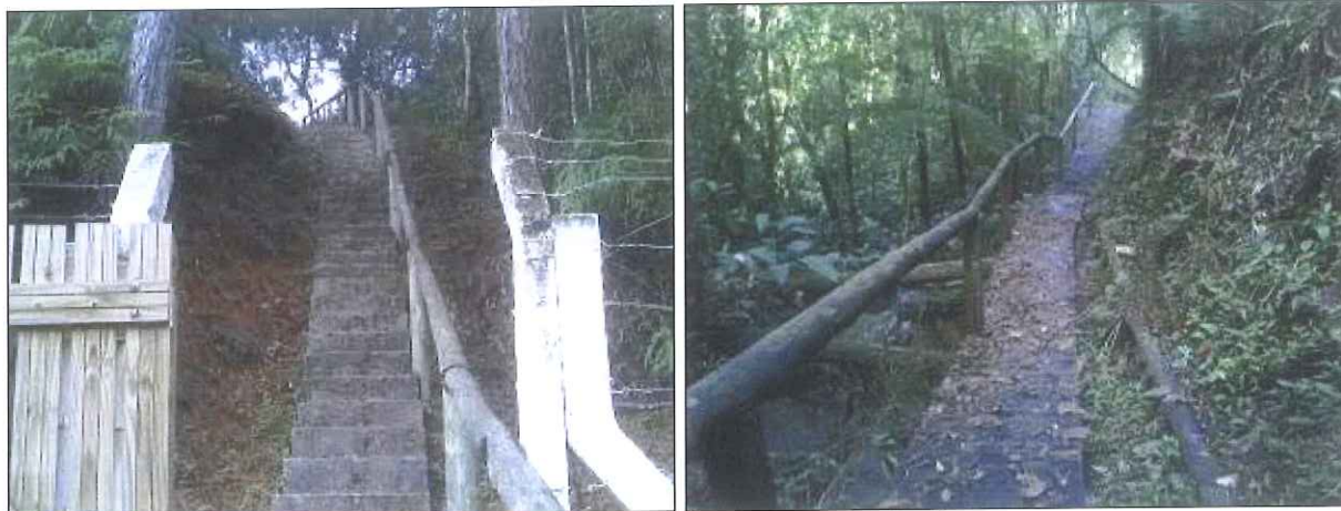
Figura 2: Melhorias no acesso a captação.
