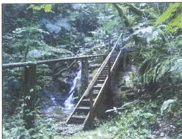
Figura 3: Melhorias no acesso à captação.
