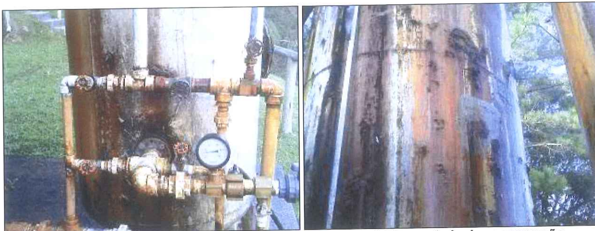
Figura 6: Estrutura do filtro e decantador da ETA em péssimo estado de conservação.
