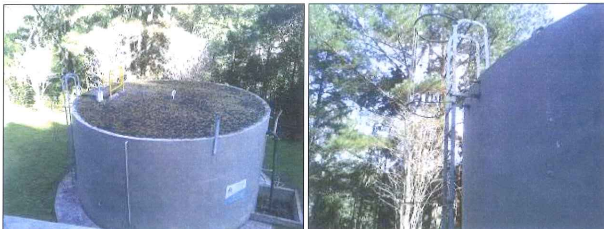
Figura 8: Escadas do Reservatório.
