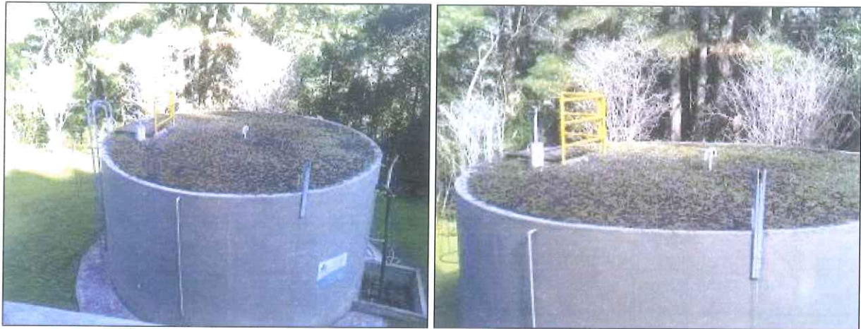
Figura 9: Guarda-corpo no reservatório somente adjacente à abertura.
