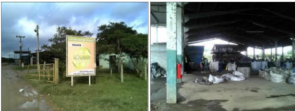
Figura 6: Galpão de triagem
