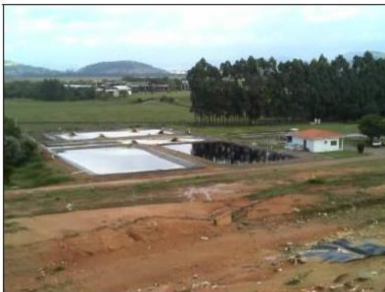
Figura 12: Drenagem de águas superficiais
