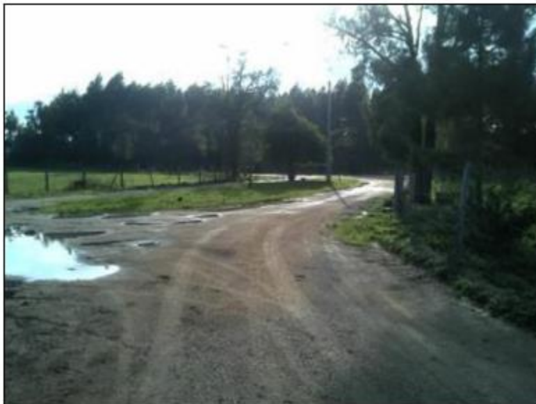
Figura 5: Acesso ao aterro e escritório
