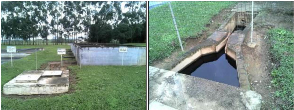
Figura 14: Sistemas de drenagem e medição de vazão do chorume (acompanhamento)
