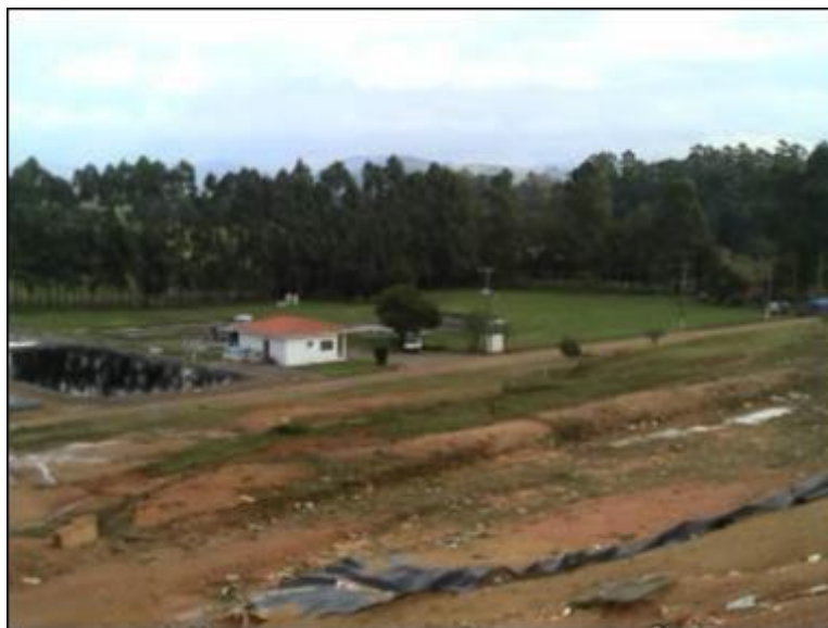
Figura 1: Vista Geral do Aterro (acompanhamento)
