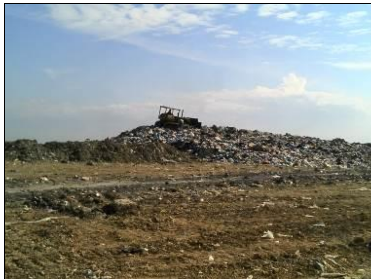
Figura 4: Máquinas que operaram no Aterro Sanitário
