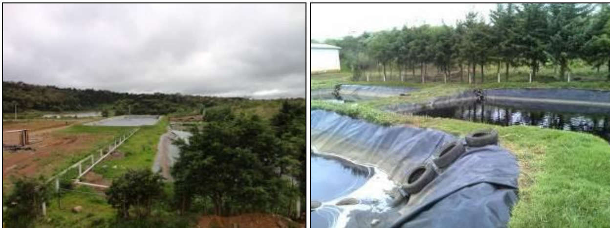
Figura 13: Sistemas de drenagem/tratamento (inicial e acompanhamento)
