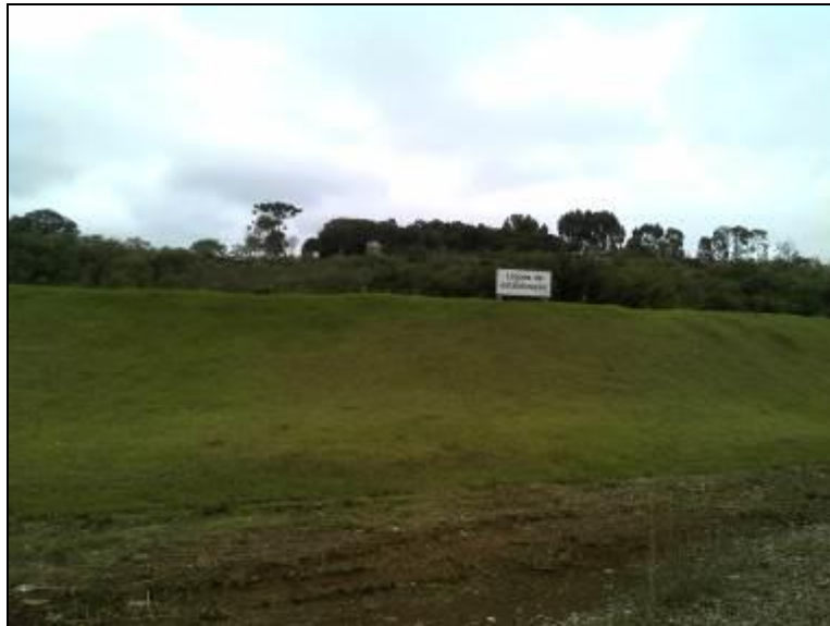
Figura 12: Drenagem de águas superficiais (acompanhamento)
