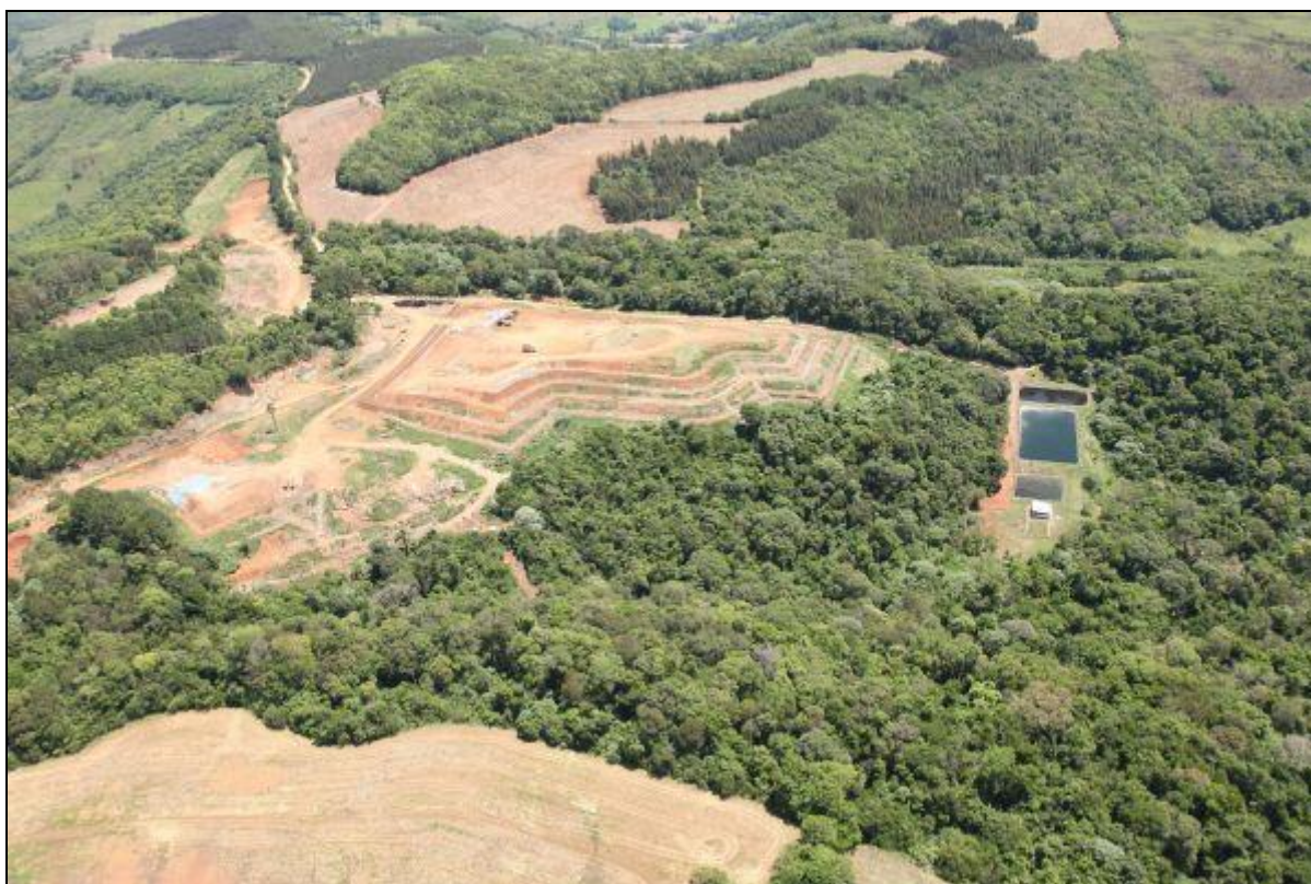
Figura 1: Vista aérea do Aterro – Unidade III (Fonte: http://grupotucano.com.br/aterros/detalhes/id/7 )
