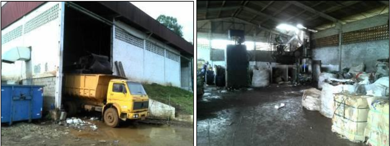
Figura 6: Galpão de triagem
