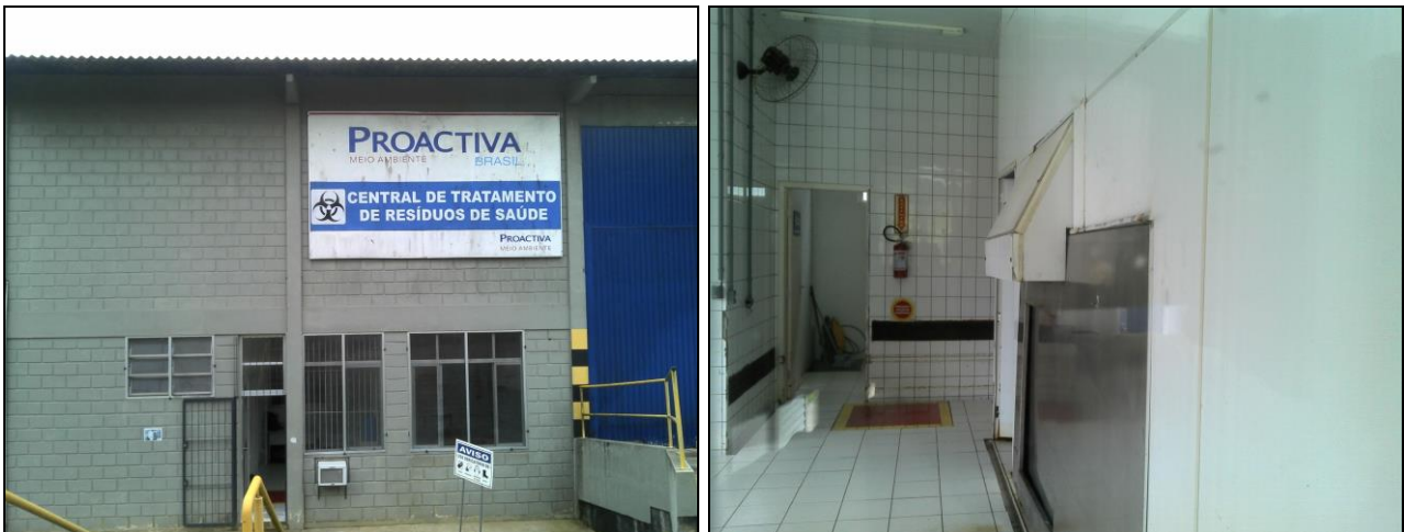
Figura 14: Depósito de Lixo hospitalar e Autoclava
