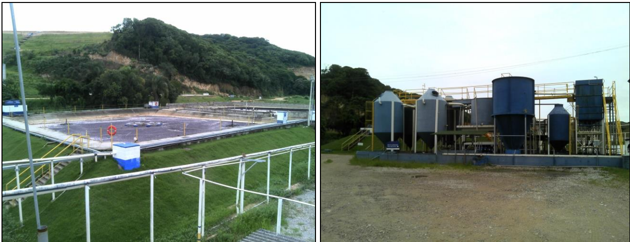
Figura 12: Lagoas de tratamento de chorume e adição de produtos químicos
