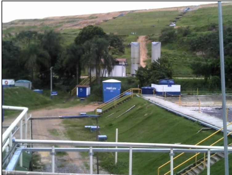
Figura 10: Drenagem de águas superficiais
