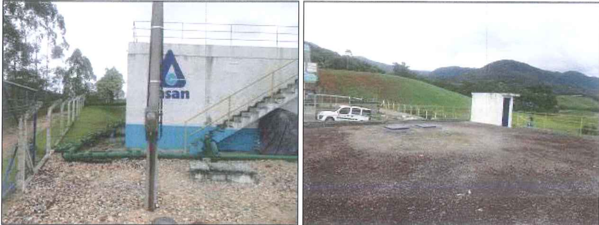
Figura 19: Reservatório junto a ETA
