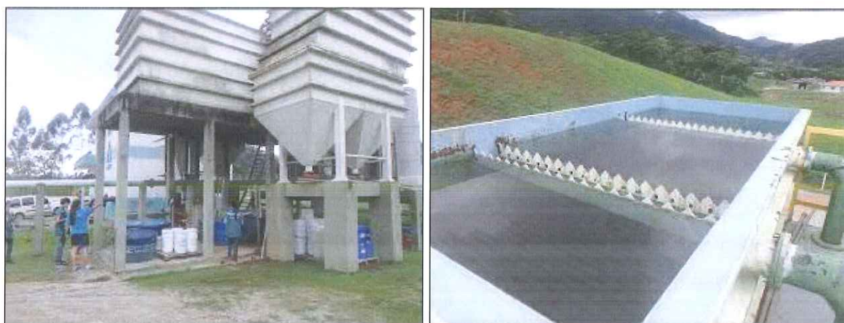
Figura 16: Decantadores da ETA
