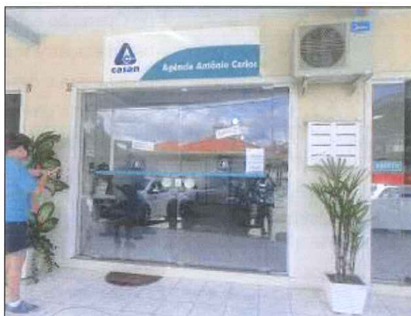
Figura 1: Fachada do escritório
