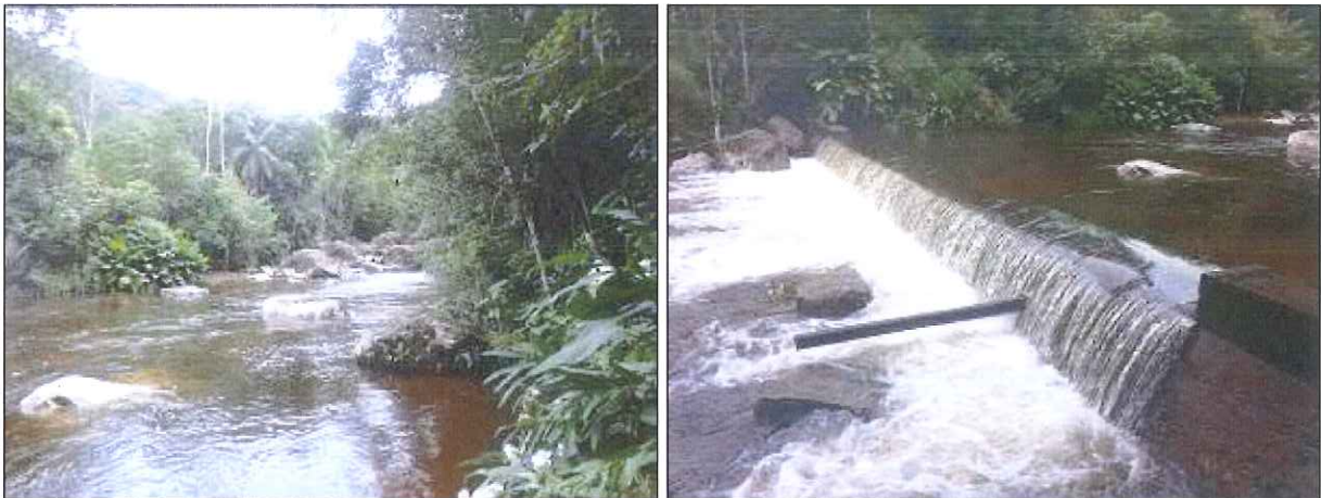
Figura 7: Represa de captação do Rio Farias
