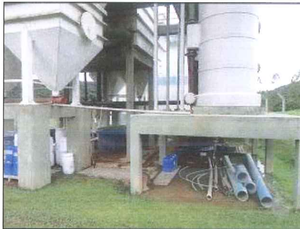
Figura 18: Produtos químicos e materiais dispostos inadequadamente
