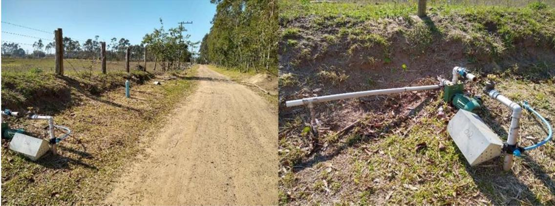
Figura 6 - Estruturas de captação subterrânea de poços desativados
